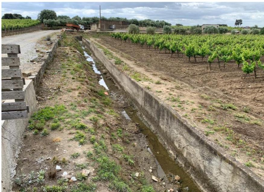
Figura 4 - Troço do ribeiro das Fontainhas onde se irá efetuar a descarga. Fonte: proponente.
