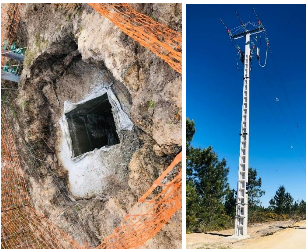
Execução das fundações dos apoios de linha e montagem dos mesmos
