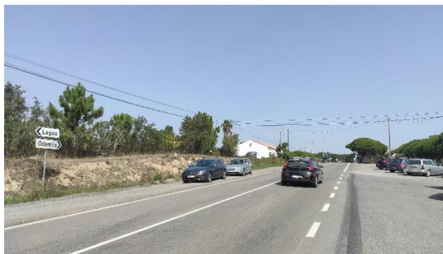
Figura 4.37 - Vista da N120 junto do restaurante "O Becha", próximo da derivação para o estradão que permite aceder à área de implantação do projeto - FOTO 2
