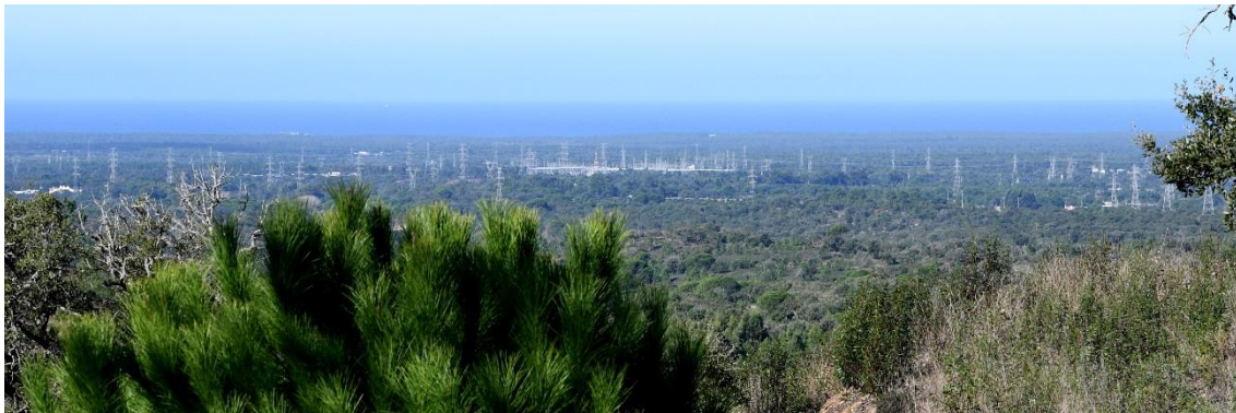
Figura 142 – Aspeto da zona envolvente à subestação de Sines a partir da zona sul da serra de Grândola, percebendo-se a elevada densidade de apoios de linha existentes na aproximação à subestação.
