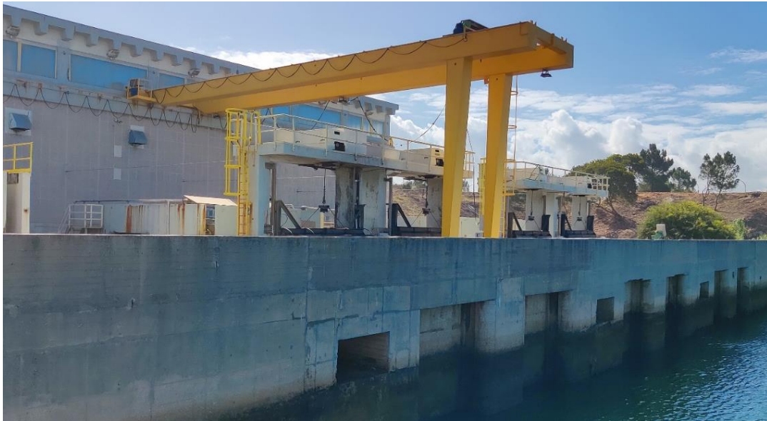
Fotografia 1 – Edifício da Estação de Bombagem da Central Termoelétrica (existente).
