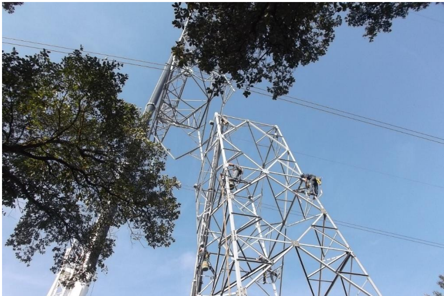
Figura 41 – Montagem da estrutura metálica de apoios de Linha Elétrica.
