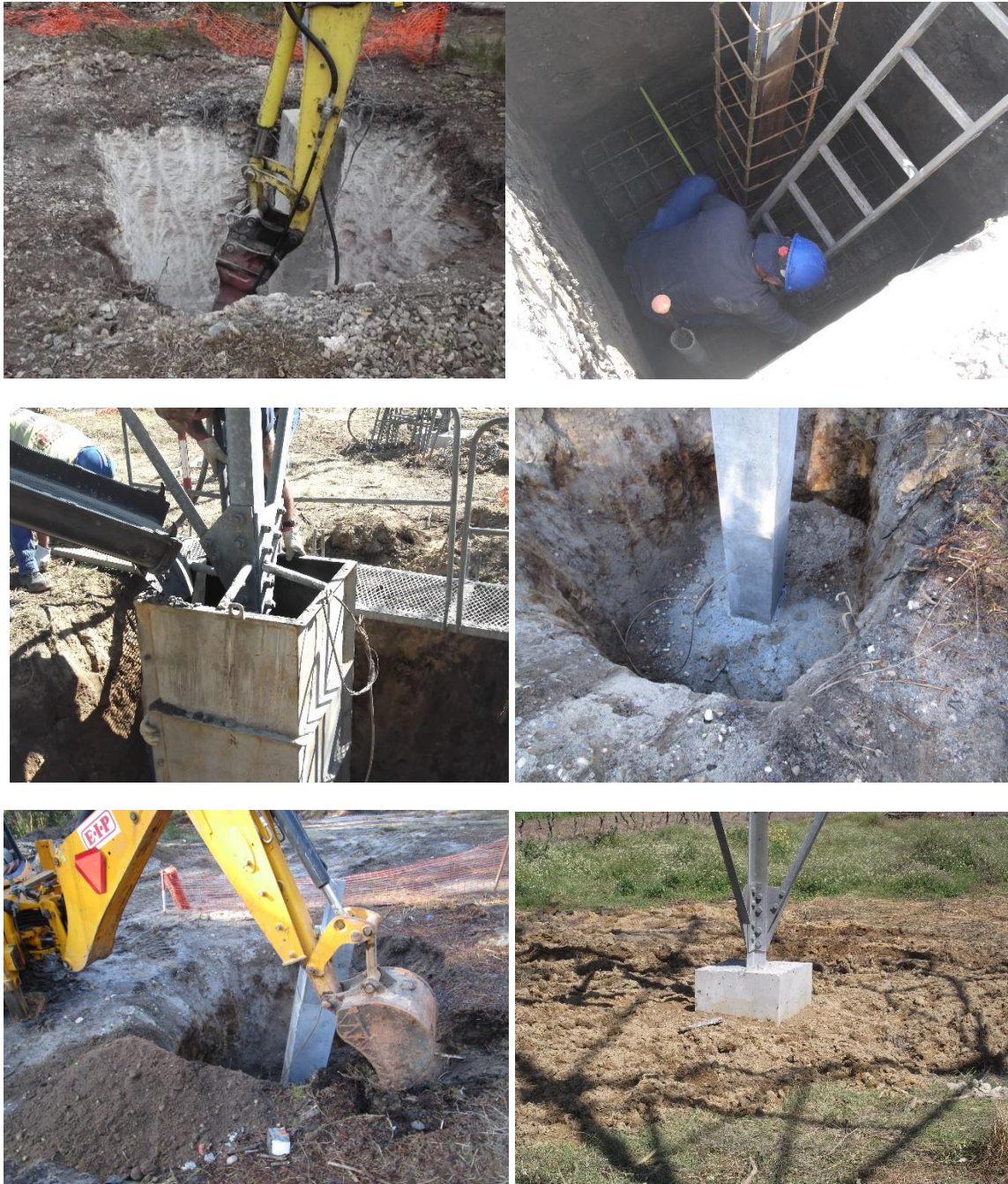
Figura 40 – Execução das fundações dos apoios de uma linha elétrica.
