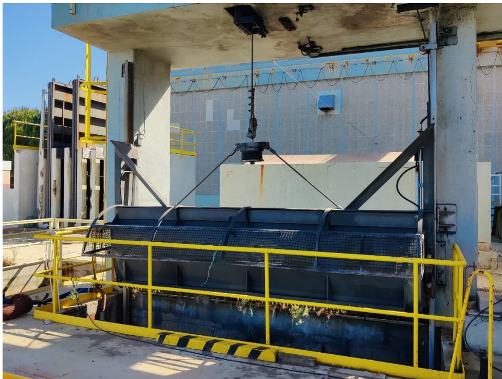
Fotografia 2 – Estruturas de filtragem para remoção de material suspenso (existente).
