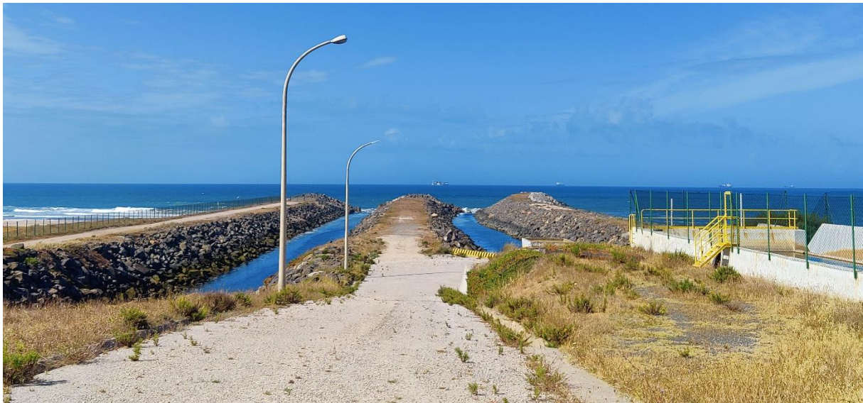
Fotografia 4 – Canais de rejeição de água da Central Termoelétrica de Sines.
