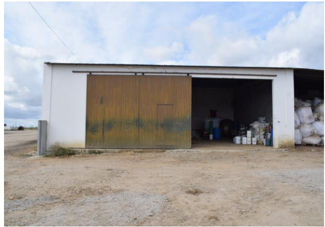
Figura 2.8 – Vista para Zona de Arrumos
