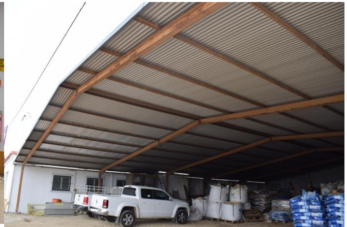
Figura 2.10 – Zona do telheiro - Arrumos
