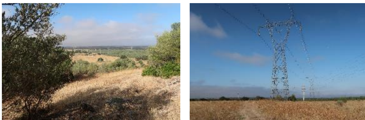
Figura 6-48 – Vistas do apoio 7 da linha Alqueva Divor para a linha existente e do apoio 8 da linha existente em direção a sudoeste.
