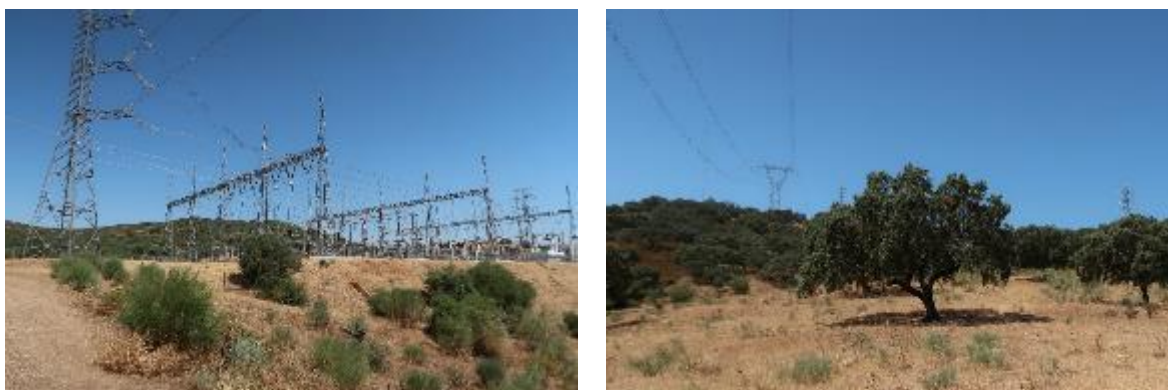
Figura 6-45 - Apoios de linha junto à subestação de Alqueva e vista a partir do apoio 2 para o apoio 3.
