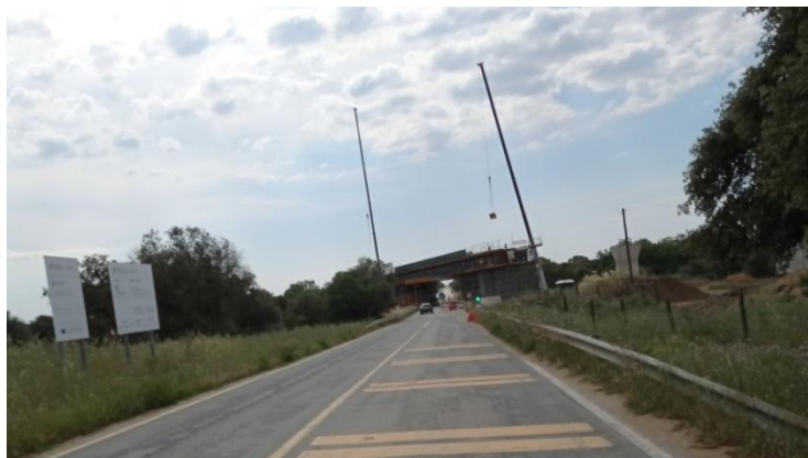
Figura 4-181 – Vista geral das obras de construção do Subtroço Évora Norte – Freixo da Nova Ligação Ferroviária entre Évora Norte e Elvas/Caia.
