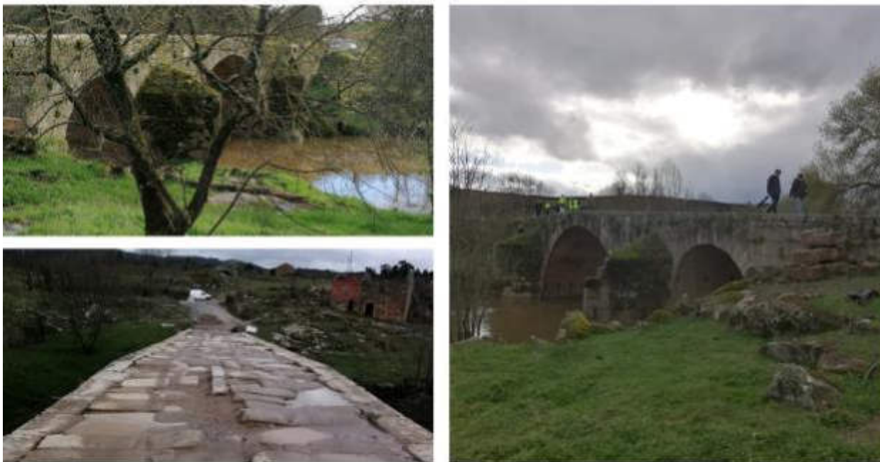
Figura 34 – Ponte de Peroviseu Visita, dia 7 de março
