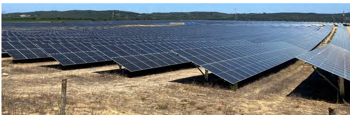
Fotografia 1 – Central Fotovoltaica com tecnologia do mesmo tipo da que se pretende instalar.
