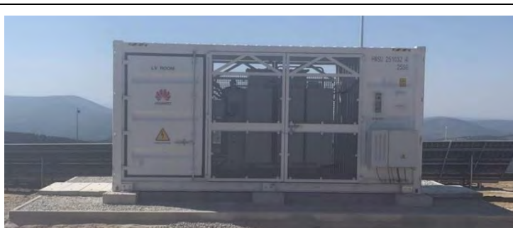
Figura 3 – Estrutura prefabricada que contém o transformador.
