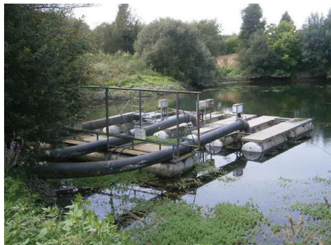
Foto 1 – Vista da captação da D.S. Smith na Correlhã
