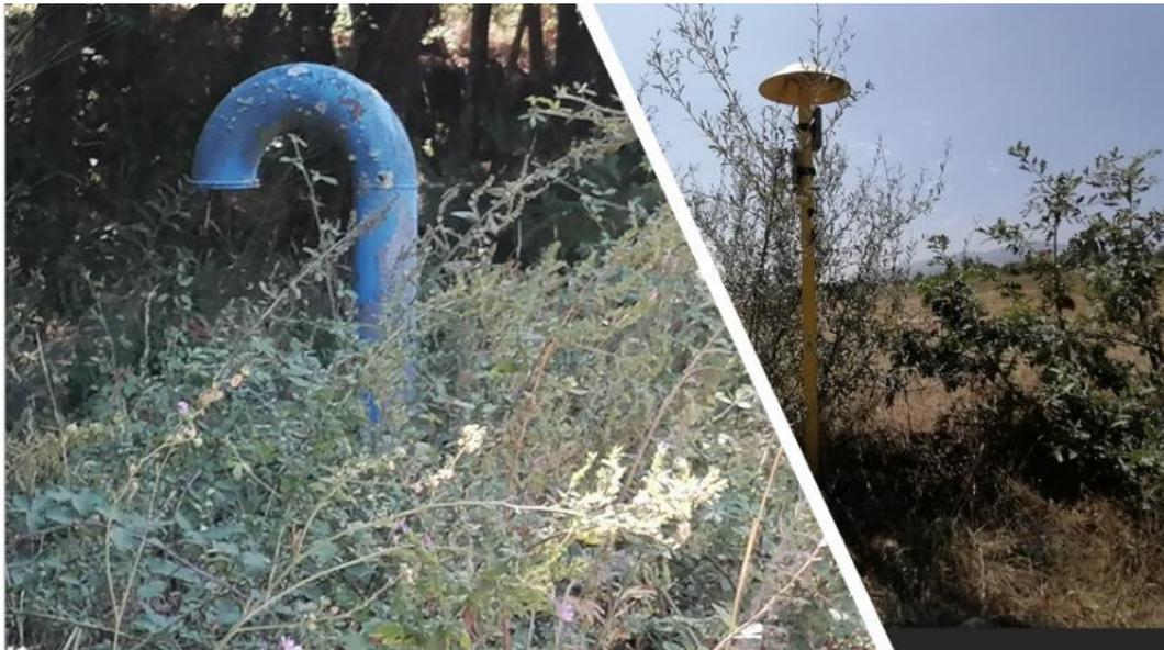
**Figura 3 – Infraestruturas da conduta de água da APAL-SIM e gasoduto**
