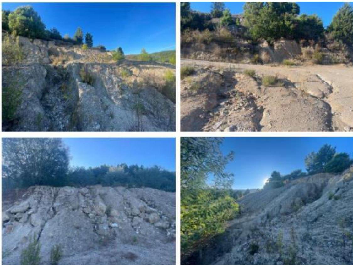
*Erosão nos taludes do núcleo n.º III, documentação de 01.09.2024*
