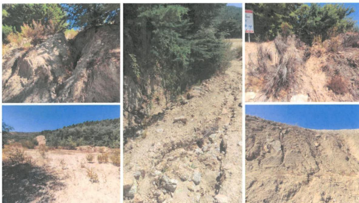
Figura 9. Erosão provocada pela escorrência de águas pluviais e acumulação em zonas planas (fotos tiradas a 25/08/2024).
