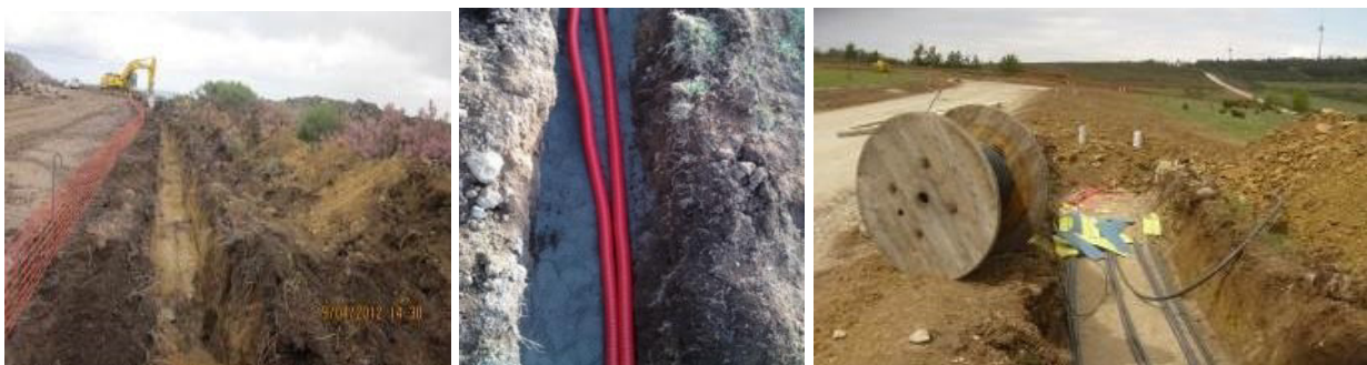
Fotografia 4.3 – Exemplo de abertura de valas para instalação de cabos elétricos
