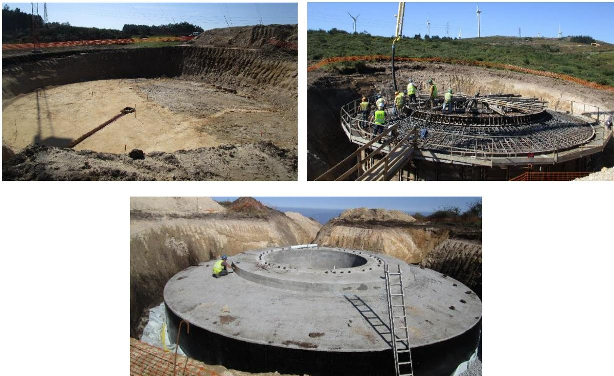
**Fotografia 3 – Execução da fundação da torre de um aerogerador (exemplificativo).**
