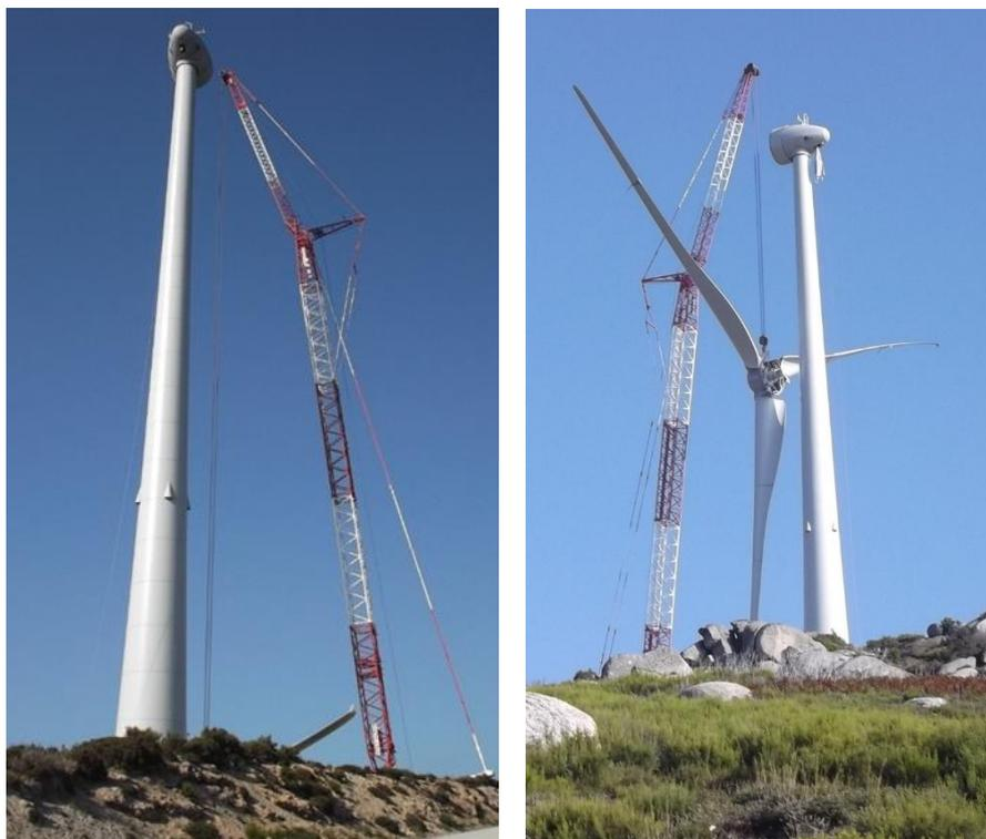
Fotografia 4 – Montagem do aerogerador (exemplificativo).
