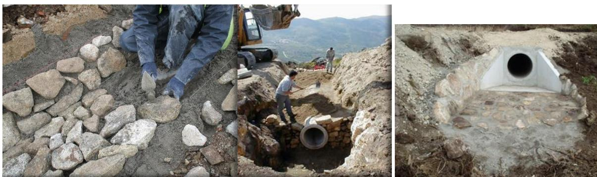
Fotografia 1 – Valeta e construção de uma passagem hidráulica.
