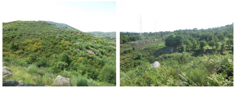
Corredor da Linha entre o P61 e o P59
