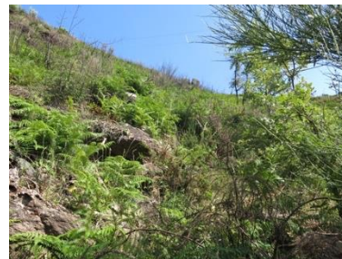
Corredor da Linha elétrica entre os apoios P51 e P47
