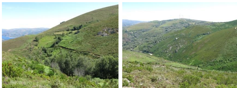
Corredor da Linha elétrica entre os apoios P18 a P14
