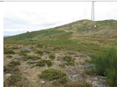
Subestação, vista de SE
