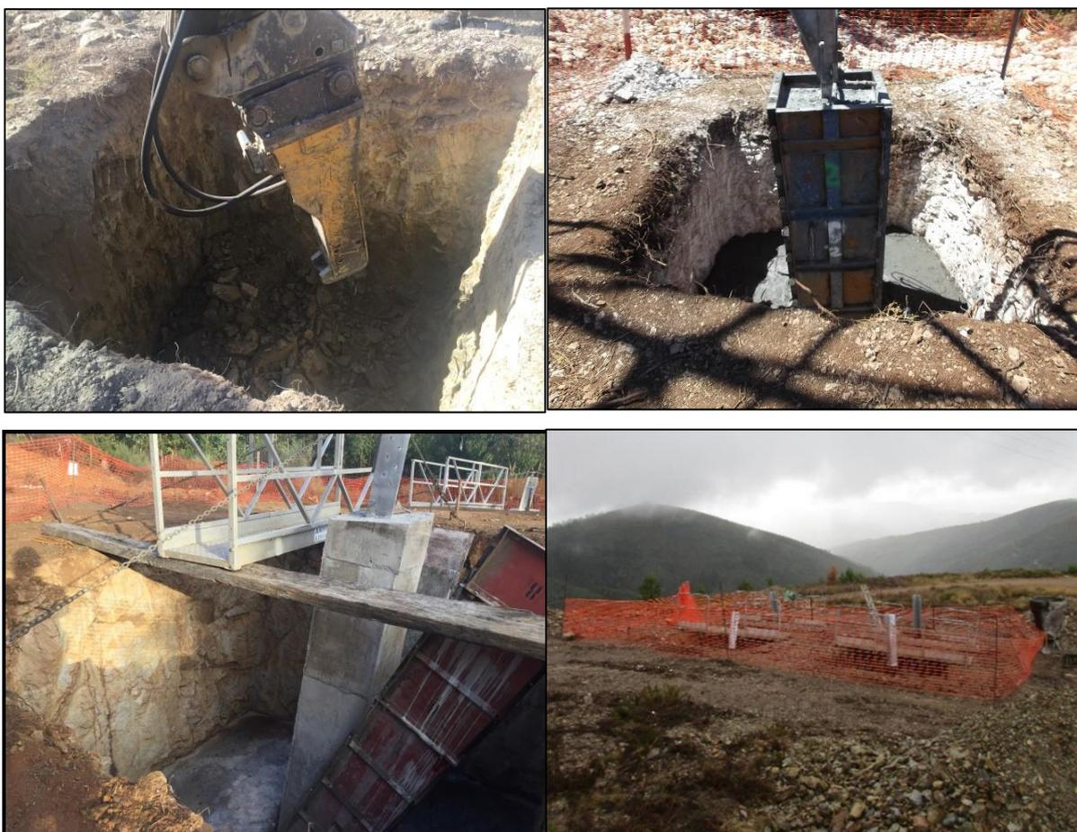
Figura 47 – Execução das fundações dos apoios de uma linha elétrica (exemplificativo).
