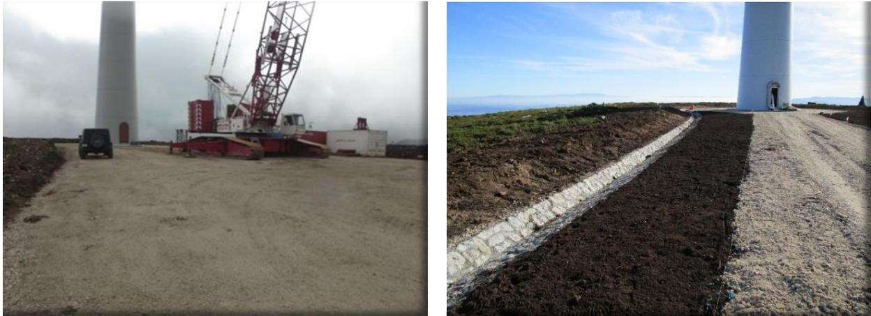
**Fotografia 3 – Plataforma de trabalho adjacente a um aerogerador à esquerda durante a fase de montagem (à esquerda) e após a recuperação paisagística (à direita) (exemplificativo).**
