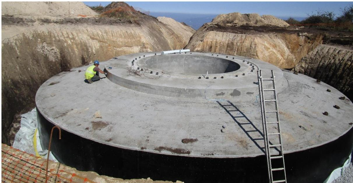
**Fotografia 8 – Execução da fundação da torre de um aerogerador (exemplificativo).**
