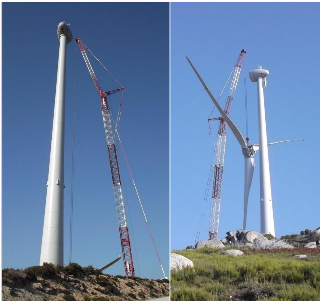
Fotografia 9 – Montagem do Aerogerador (exemplificativo).
