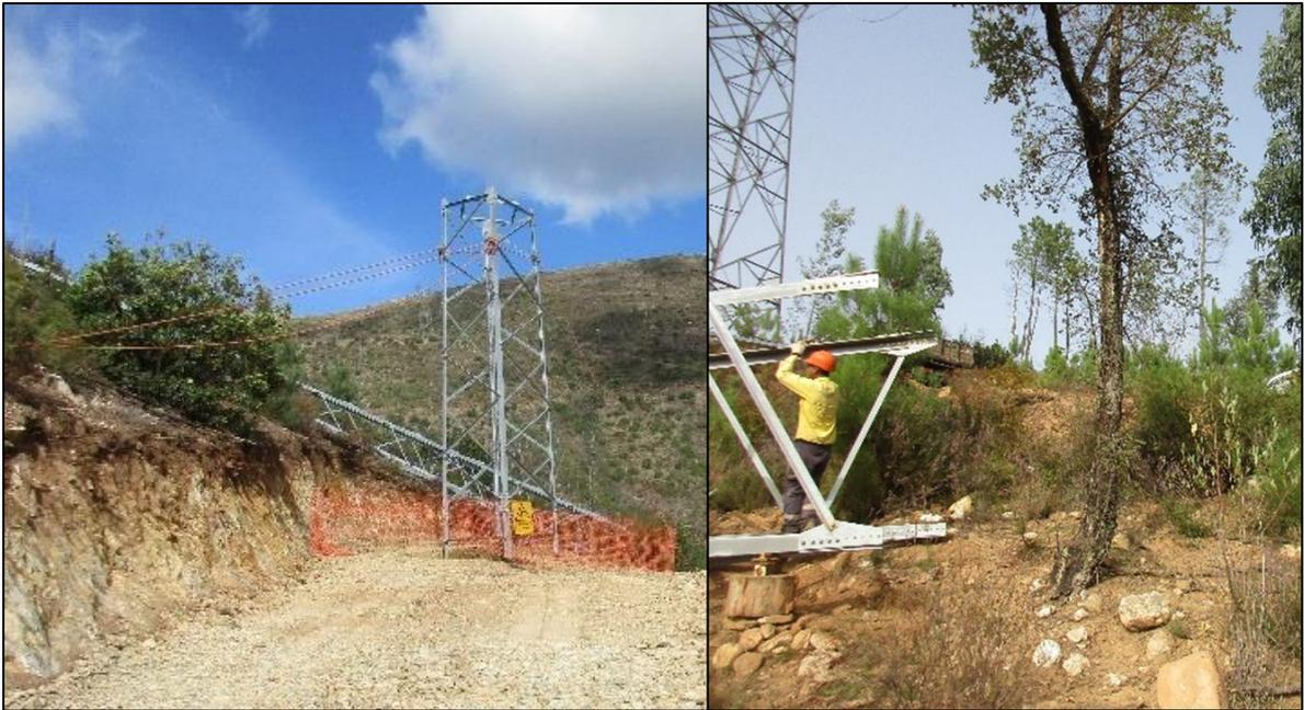
**Figura 48 – Montagem da estrutura metálica de apoios de Linha Elétrica (exemplificativo).**
