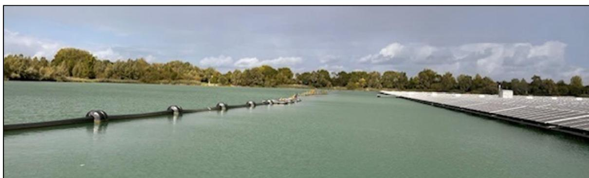
Fotografia 1 – Exemplo do aspeto geral da barreira (num dos segmentos das ilhas) constituída por tubos de material plástico com flutuadores de forma a proteger as ilhas.
