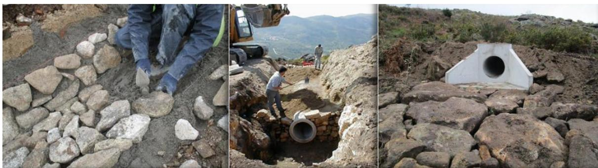
Fotografia 6 – Valeta e construção de uma passagem hidráulica (exemplificativo).
