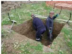
Escavação dos caboucos
