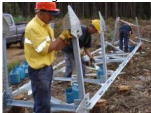
Montagem de um apoio
