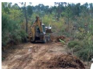
Trabalhos de desmatamento
