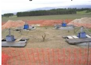
Vista após Betonagem
