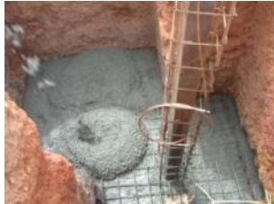
Betonagem do cabouco
