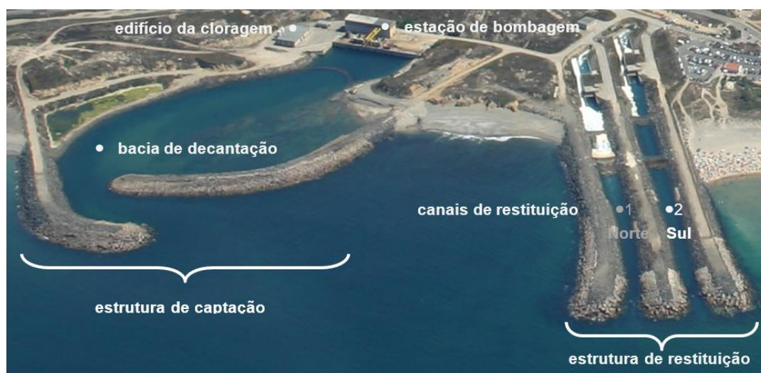
Figura 8 – Estruturas de captação e restituição/descarga de água da CTS
