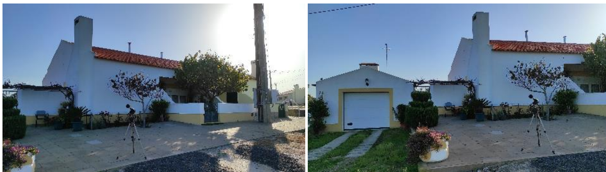
Figura 2 – Apontamento fotográfico Ponto 1
