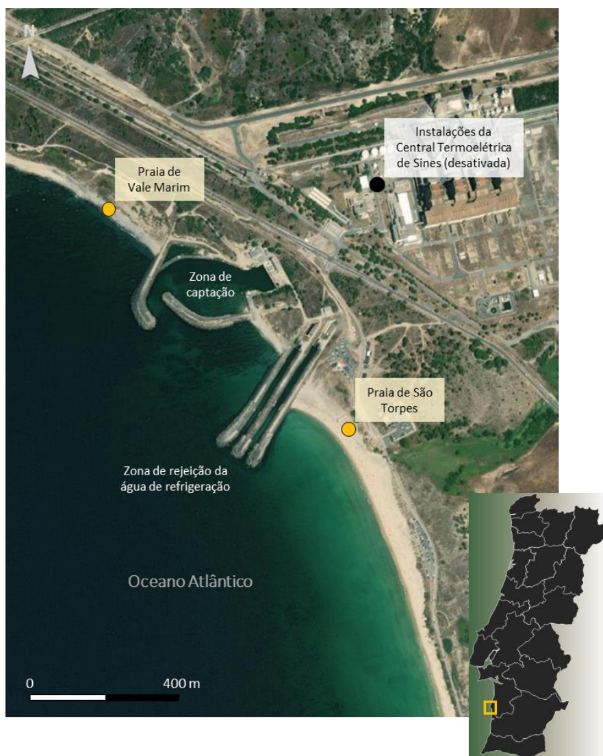
Figura 5.75 – Localização das zonas de captação e de rejeição da água de refrigeração da Central Termoelétrica de Sines (CTS), atualmente em desativação
