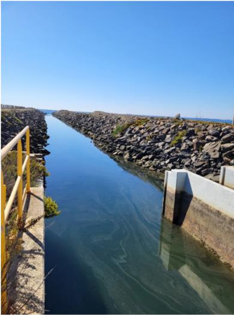
Figura 5.76 – Vista para o canal sul da estrutura de rejeição da CTS no sentido da descarga (fotografia obtida aquando da visita realizada no dia 14/10/2022)
