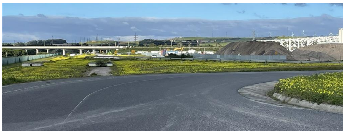
Enquadramento do lado nascente da esteira de carvão, com construção, no terreno do antigo Aeródromo de Sines, do Hyperscaler Data Center SINES 4.0 – 1ª Fase - Projeto NEST, entre a CTS e a linha férrea de acesso ao porto de Sines.
