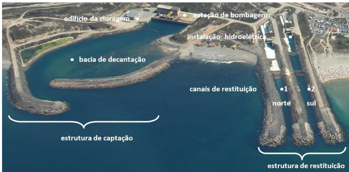
Figura 4.10 – Estruturas de captação e restituição/descarga de água da CTS
