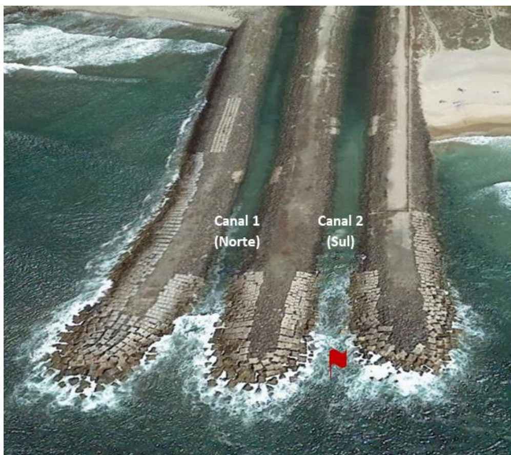
Figura 4.15 – Estrutura de restituição (Canal 2 - Sul) e ponto de descarga no Oceano Atlântico ( ǂ )
