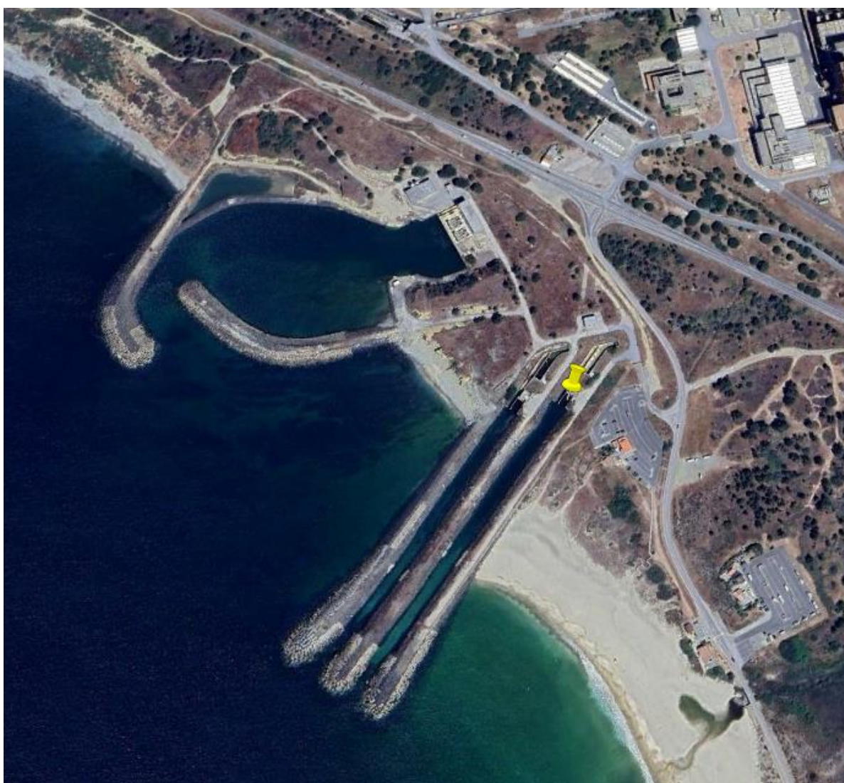
Figura 13.1 – Saída da água de rejeição do sistema de refrigeração do Projeto GH2A (solução base) e proposta de localização do ponto de amostragem (a amarelo) para monitorização cloro e pH
