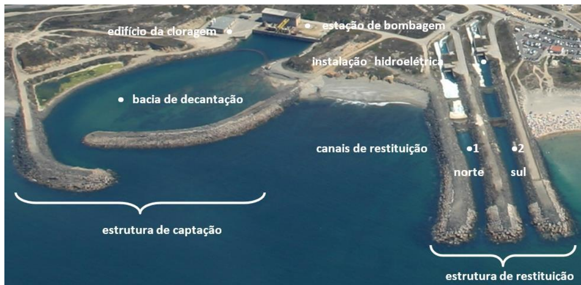
Figura 7.7 – Estruturas de captação e restituição/descarga de água da CTS
