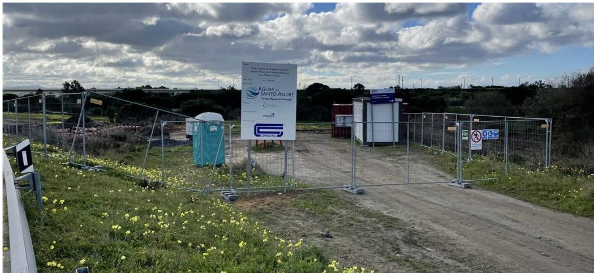
Enquadramento da intervenção na Conduta Adutora ETA-Monte Chãos, Caixa de Vale Marim.
