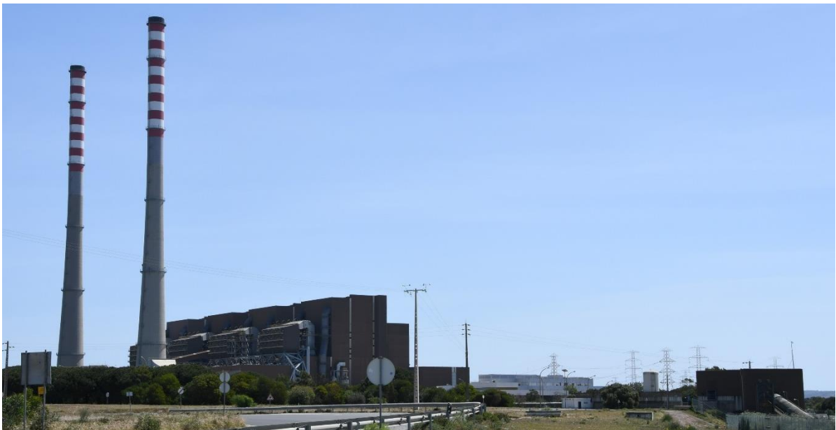
Figura 7.25 – Aspetos da zona onde está prevista a construção da unidade de produção de Hidrogénio e envolvente próxima.
