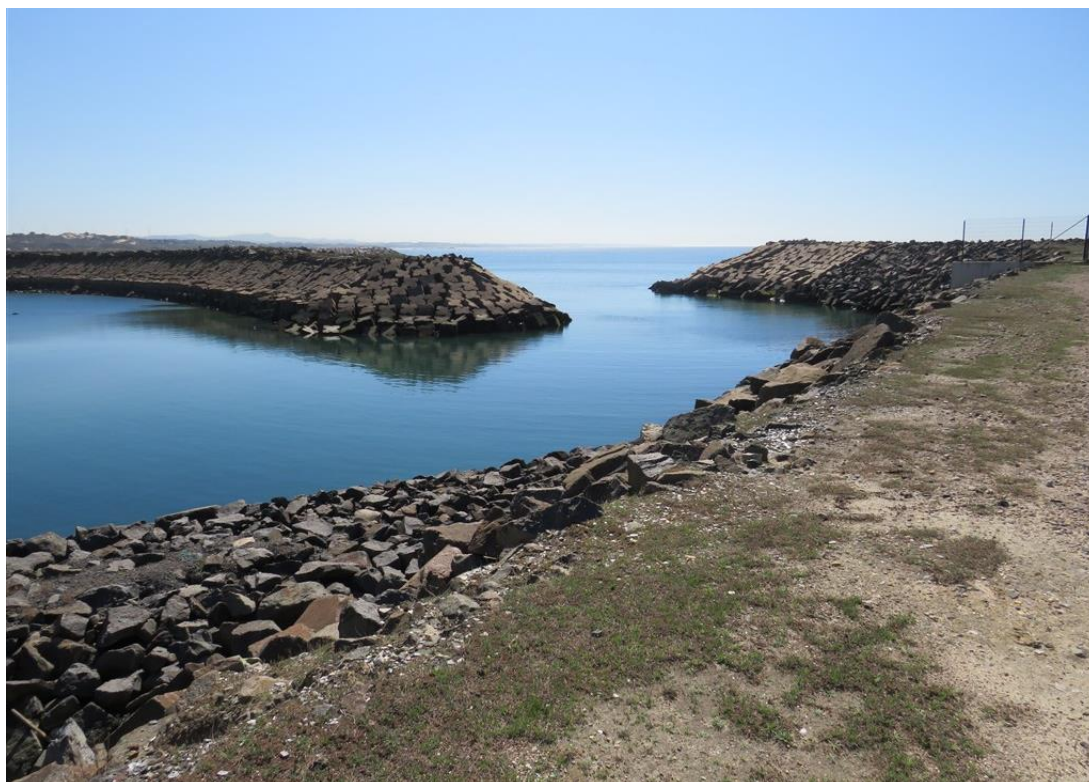
Enquadramento da captação de água da antiga CTS, vista para poente.
