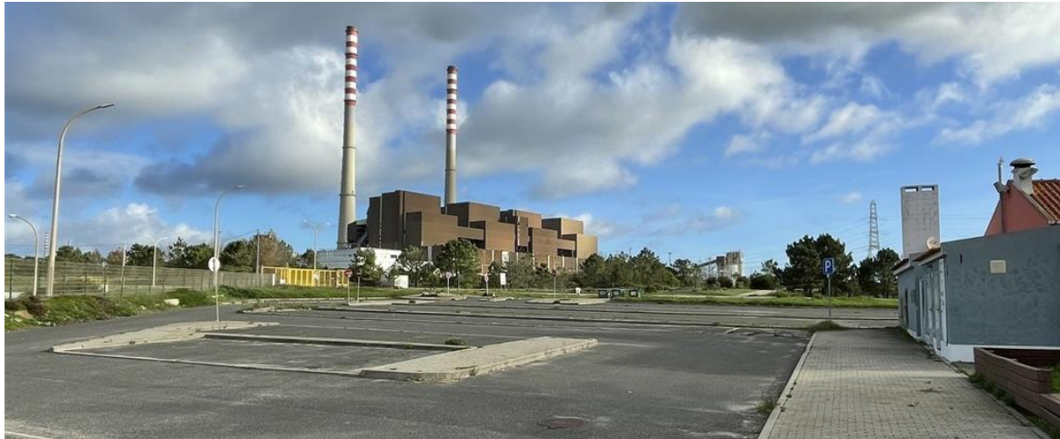
Vista para CTS, com logradouro/estacionamento e apoio de praia Kalux BEACHBAR AND SURF, Praia de São Torpes.
