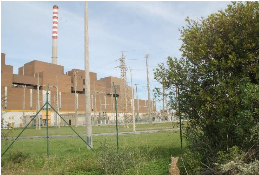
Figura 5.71 – Central termoelétrica em fase de desativação
