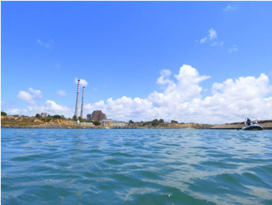
Figura 8 – Vista da CTS no interior da bacia de captação e da embarcação de apoio.
