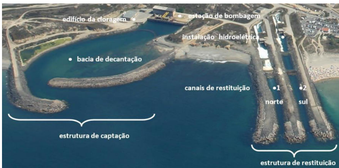
Figura 2– Estruturas de captação e restituição/descarga de água da CTS
