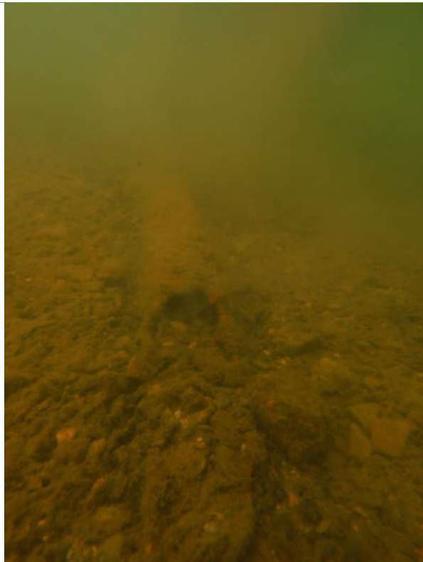
Figura 3 – Pormenor do extremo SW do tubo. Zona fraturada e parcialmente enterrado.
