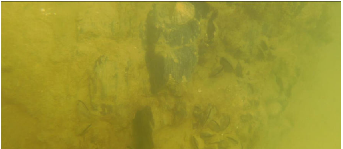
Figura 6 – ‘Frame’ de vídeo. Zonamento interior da bacia de captação. Rocha em xisto com cobertura de mexilhão.
