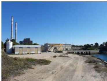
04 – Zona de captação de água
