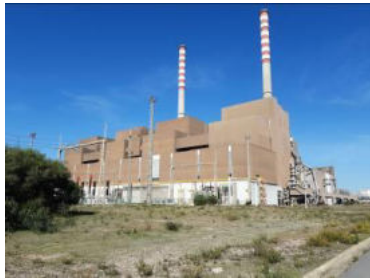
01 – Início do gasoduto na Central Termoeétrica de Sines
