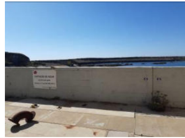
03 – Zona de captação de água
