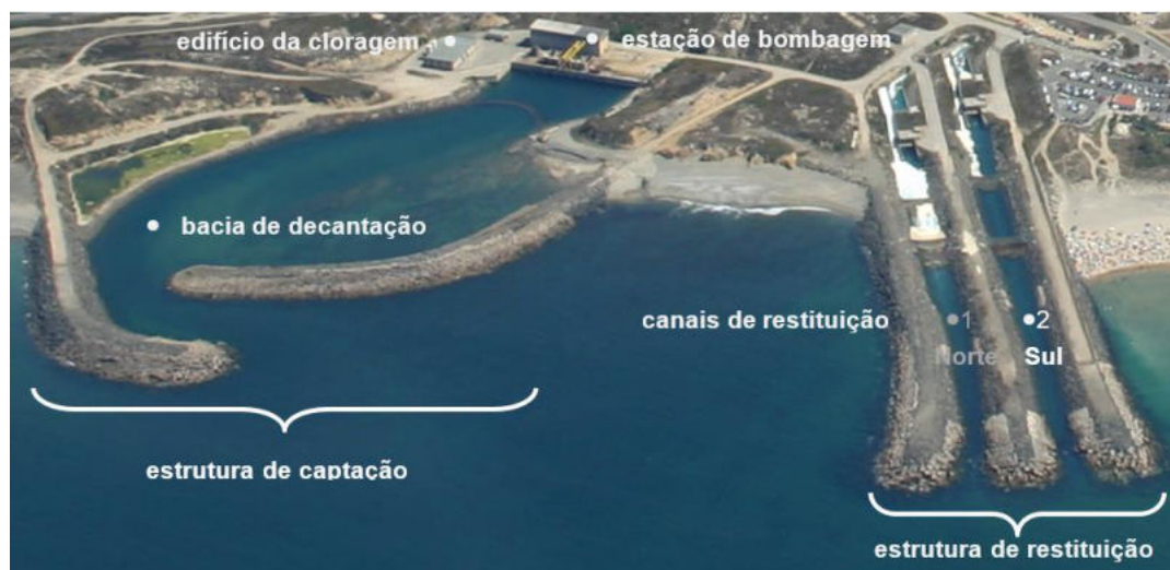
Figura 9 – Estruturas de captação e restituição/descarga de água da CTS
