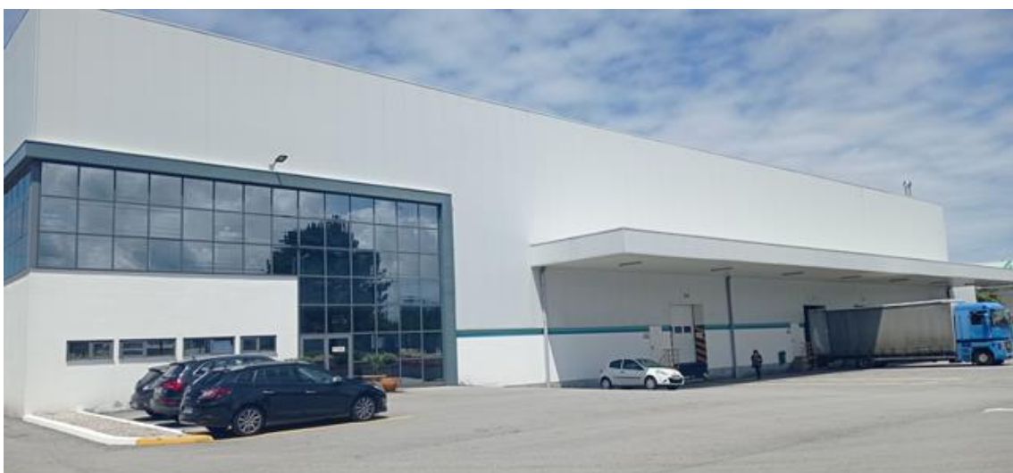
Figura 3 – Edifício da FLEXPUR.
