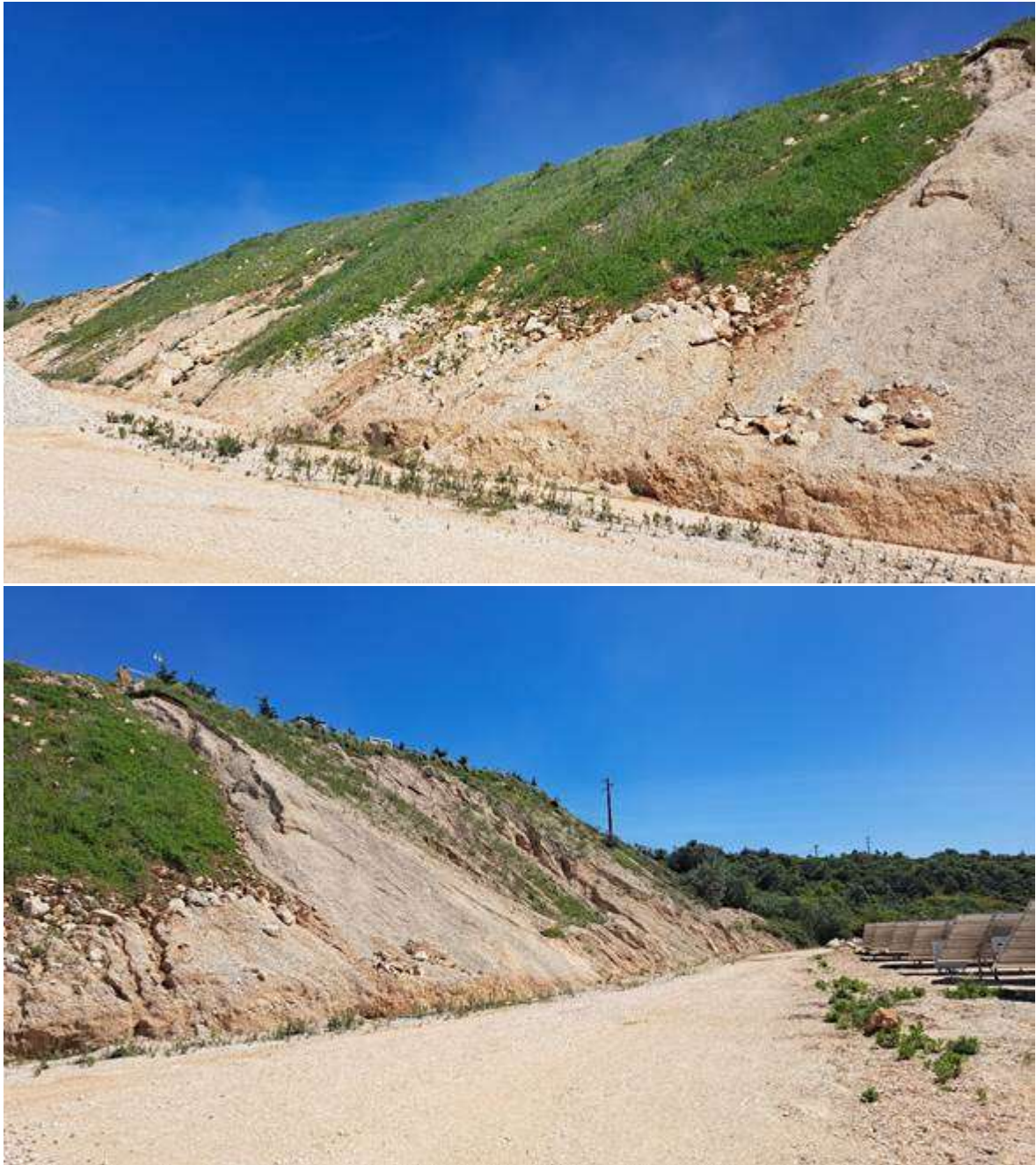
Figura IV.14 - Talude envolvente ao parque fotovoltaico.
