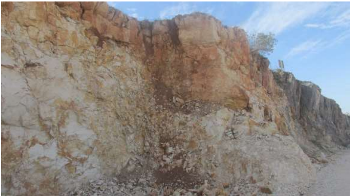
Figura III.6 – Aspeto da zona superficial fraturada e carsificada.
