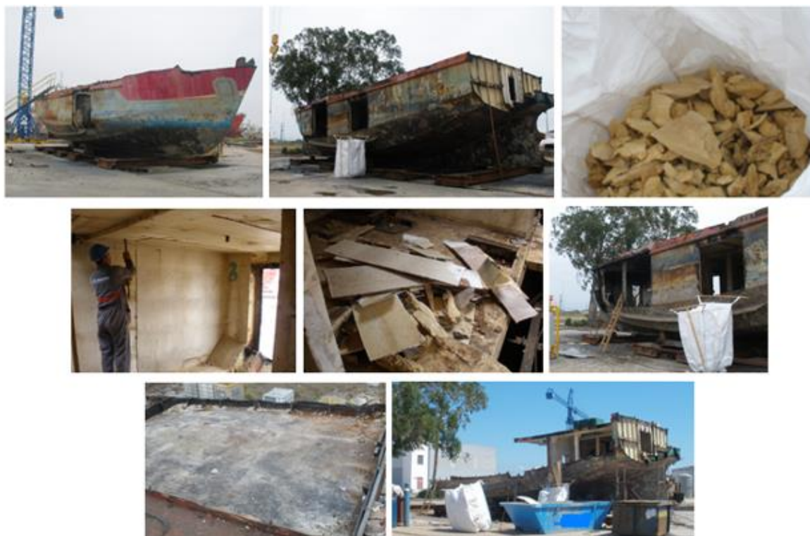
Figura 3.17- Abertura(s) de acesso ao navio facilitando ventilação dos espaços e movimentação dos resíduos a retirar do interior.
