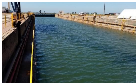
Figura 3.9- Enchimento da doca seca para docagem do navio Sta. M. a Manuela.
