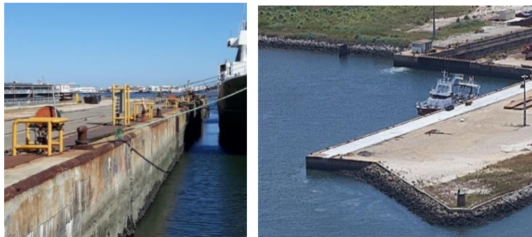
Figura 3.5- Cais de acabamento (à esquerda) e área de apoio - Zona Livre (à direita).
