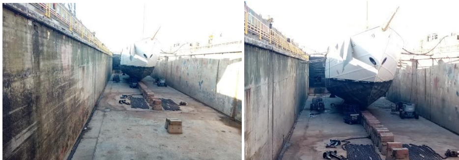
Figura 3.13- Termo da receção do navio, vazamento total da doca e retiro dos ferros do navio e, alocação de meios de movimentação e elevação de cargas e pessoas.
