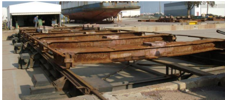
Figura 3.7 - Montagem do carro de encalhe, em plano horizontal.
