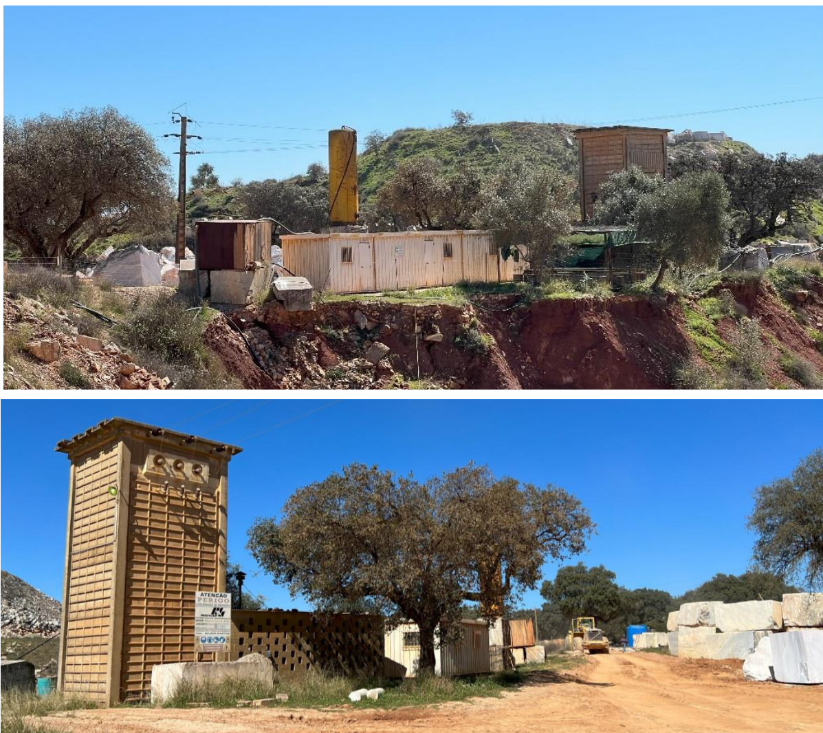
Figura 14. Instalações sociais e anexos.
