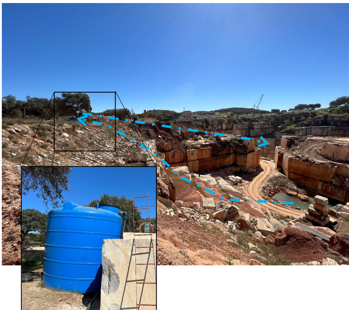
Figura 61. Captação e distribuição de água para fins industriais.
