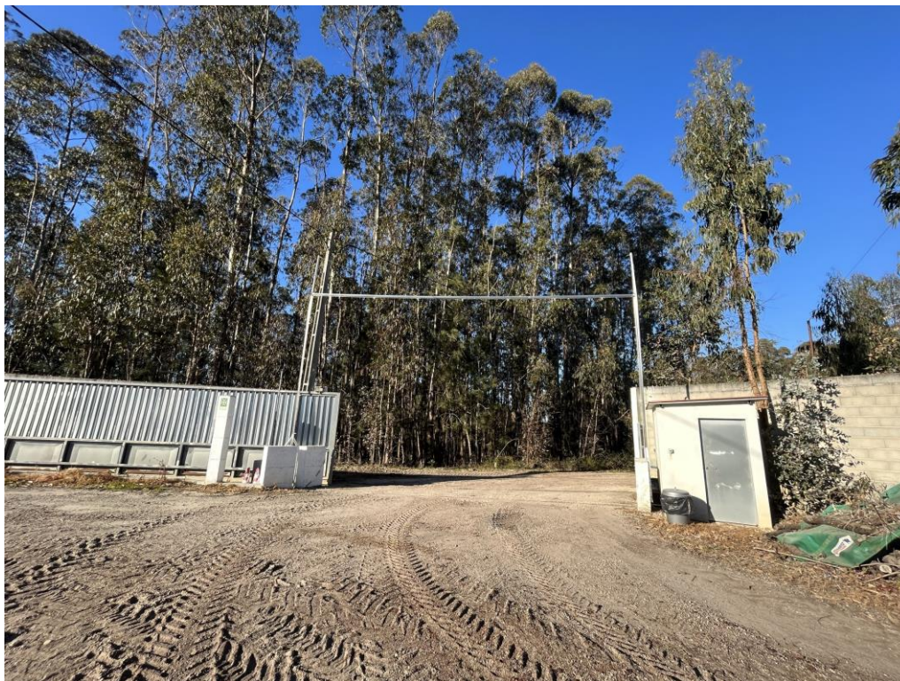
Figura 3.1.2. Entrada do Aviário, Arco de Desinfecção e Casa do Arco
