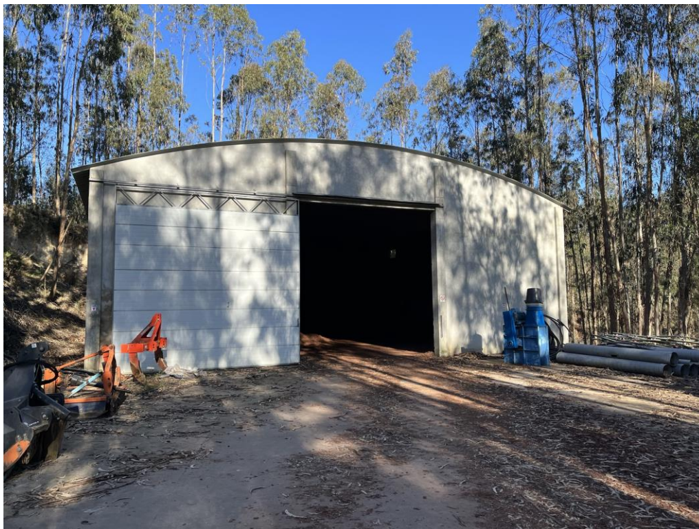
Figura 3.1.8. Pavilhão de armazenamento temporário de Estrume
