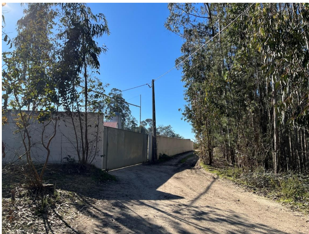
Figura 3.1.1. Portão de acesso ao interior do Aviário
