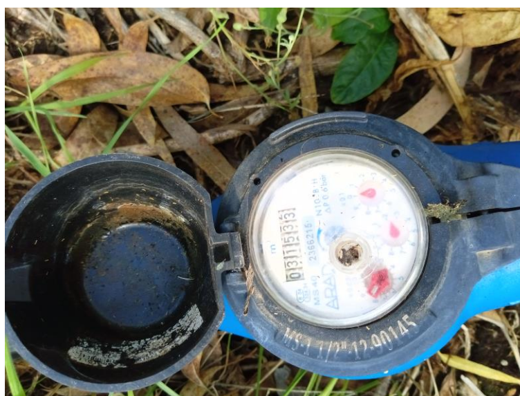
Figura 3.4.2. Fotografia do contador instalado à saída da captação de água subterrânea (AC1)
