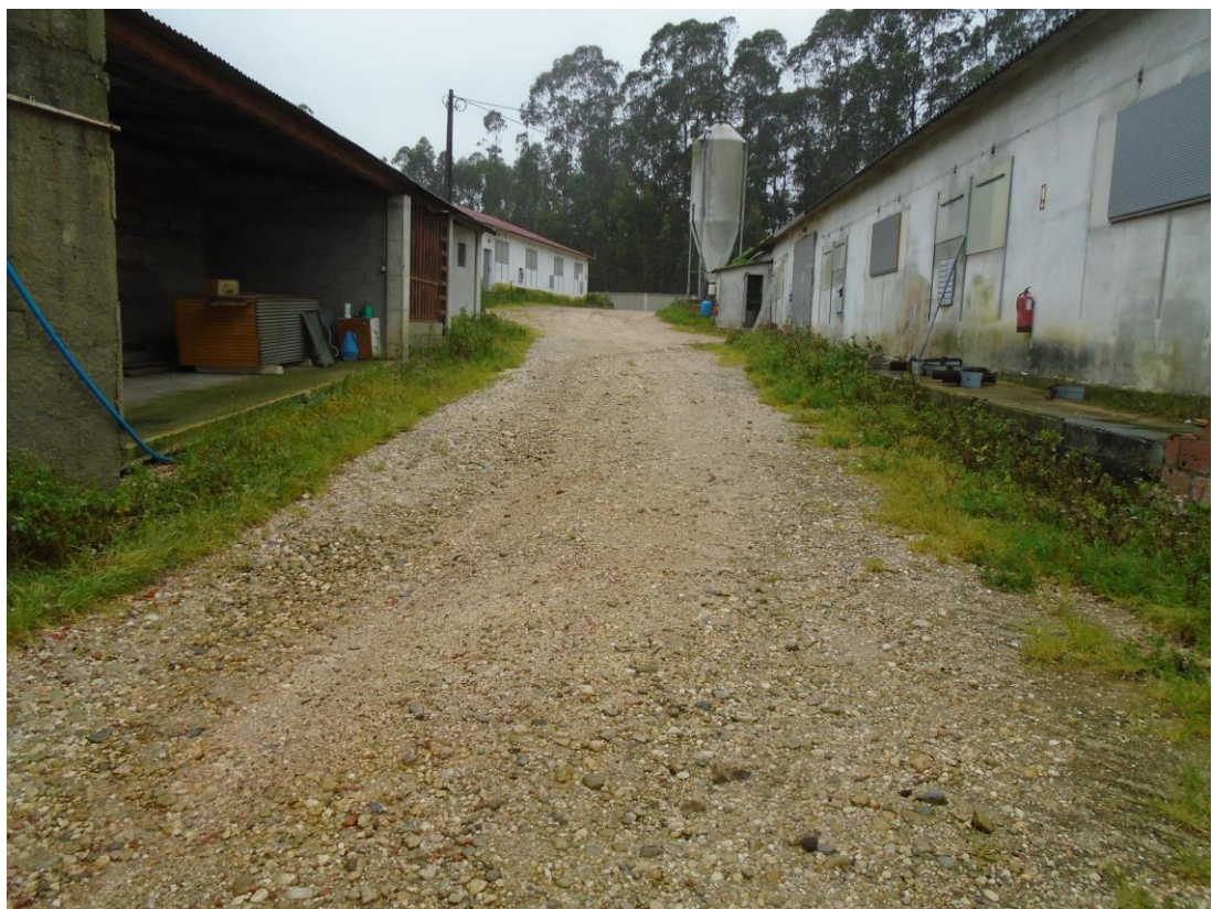
Figura 8 – Vista geral entre o pavilhão 1 e 2.
