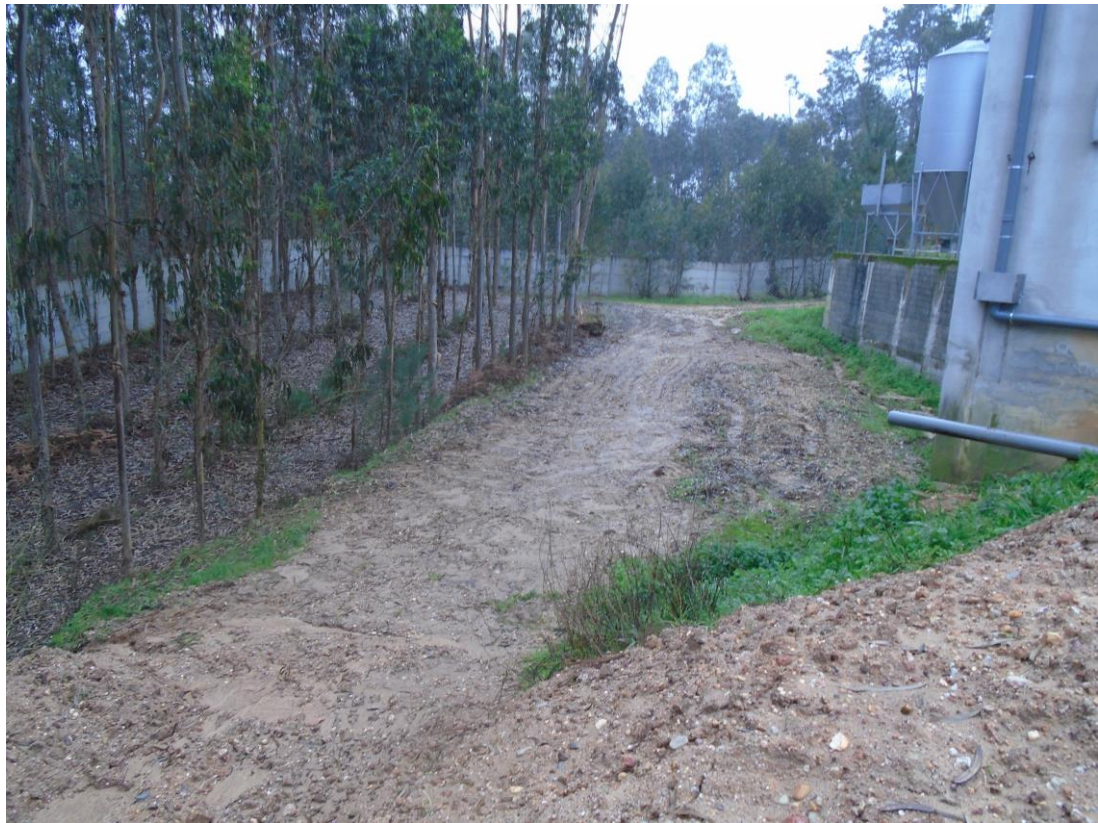
Figura 15 – Vista para Oeste do muro que delimita a propriedade.
