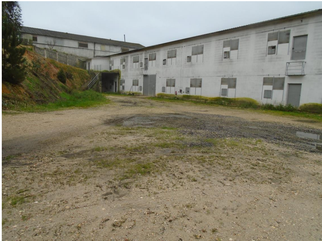
Figura 9 – Vista da área de acesso ao pavilhão 3 e do talude à esquerda.
