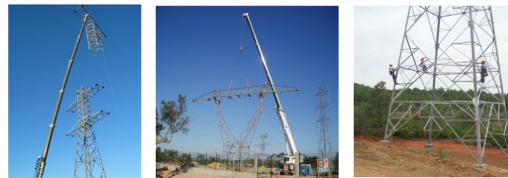
Montagem de apoios de linha
