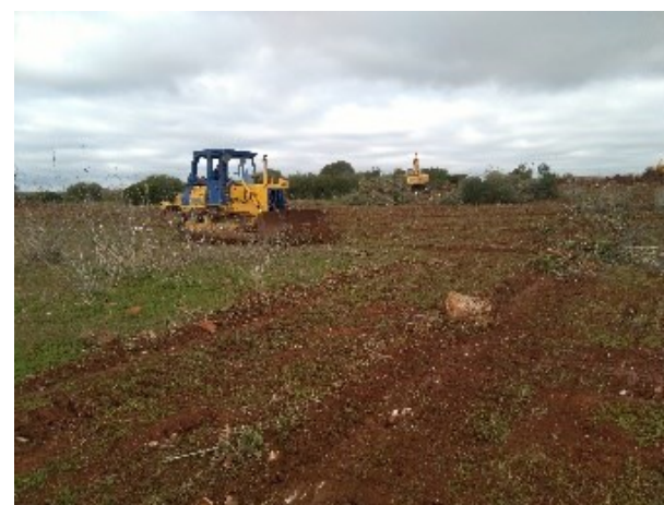
Desmatação e decapagem
