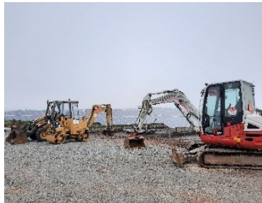
Operação de estaleiro e maquinaria de obra
