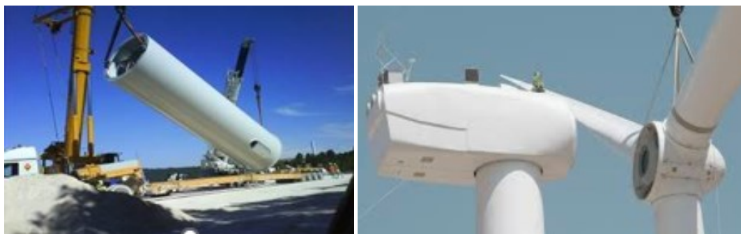
Assemblagem de aerogeradores
