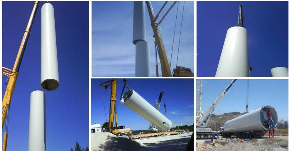
**Fotografia 2.16 – Exemplo de trabalhos de montagem da torre de um aerogerador.**
