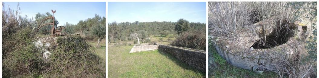
**Fotografia 6.34 - “Lameira 17”, vista geral do poço, canalização e tanque, todos constituintes da mesma estrutura (esquerda e Centro) e Pormenor de um poço, onde se observa o arco em tijolo de apoio ao engenho metálico “Lameira 25” (direita)**
