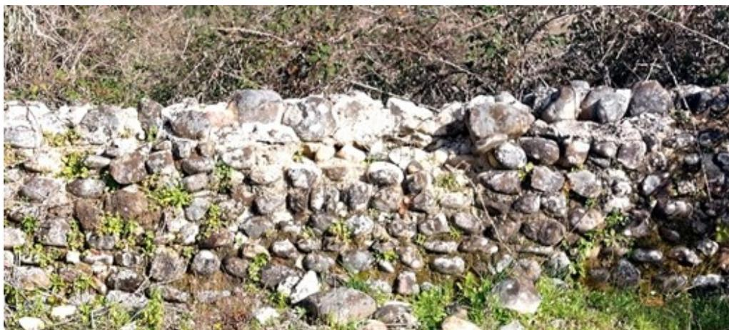
**Fotografia 6.36 - Pormenor de um muro, construído com seixos e abobe**
