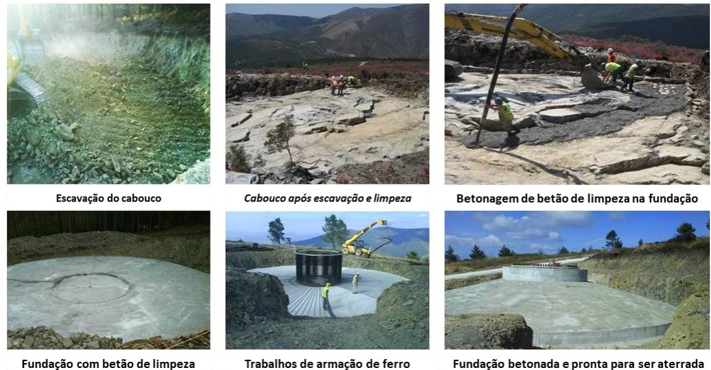
**Fotografia 2.13 – Exemplo de execução da fundação de um aerogerador.**
