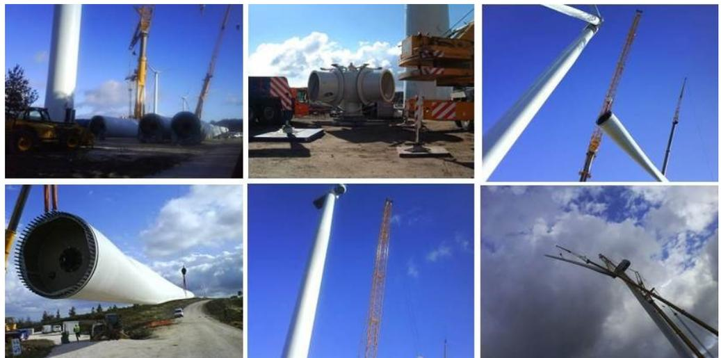
**Fotografia 2.17 – Exemplo de transporte e montagem das pás de um aerogerador.**
