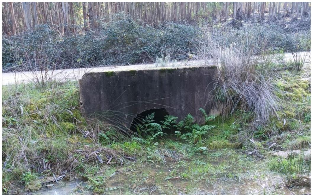
**Fotografia 2.2 – Passagem hidráulica existente na linha de água da REN, junto ao aerogerador CR-14.**
