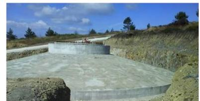
Fundação betonada e pronta para ser aterrada
