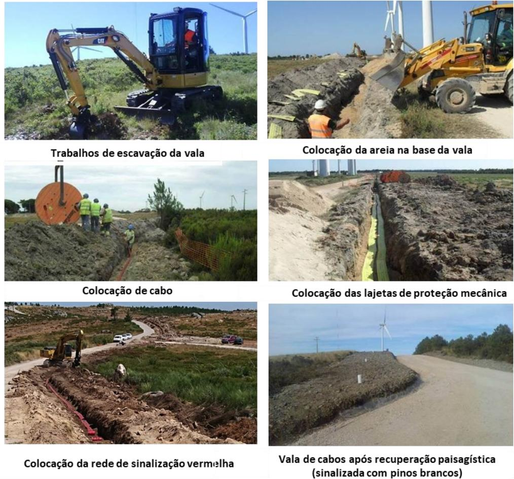
**Fotografia 2.14 – Exemplo de construção da rede elétrica interna.**
