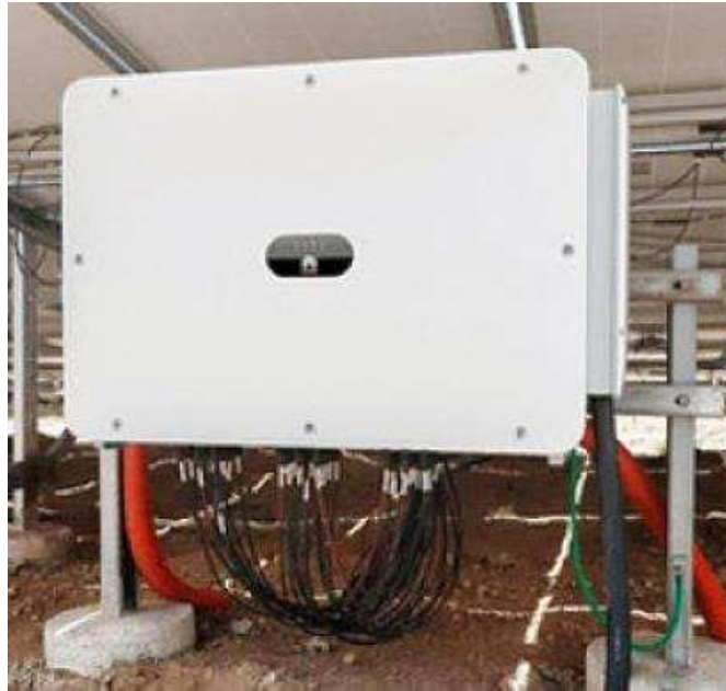
Figura 5.2 – Imagem representativa de inversor a implementar na CFA
