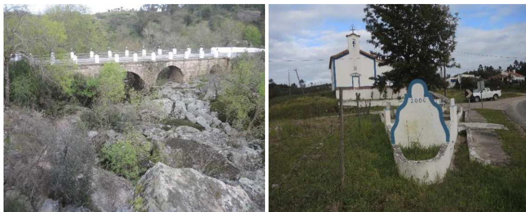
Fotografia 7.43 - Vista geral da “Ponte de Sume “CC20 e CC21 e 22 “Capela e Fonte de Moinho do Torrão”
