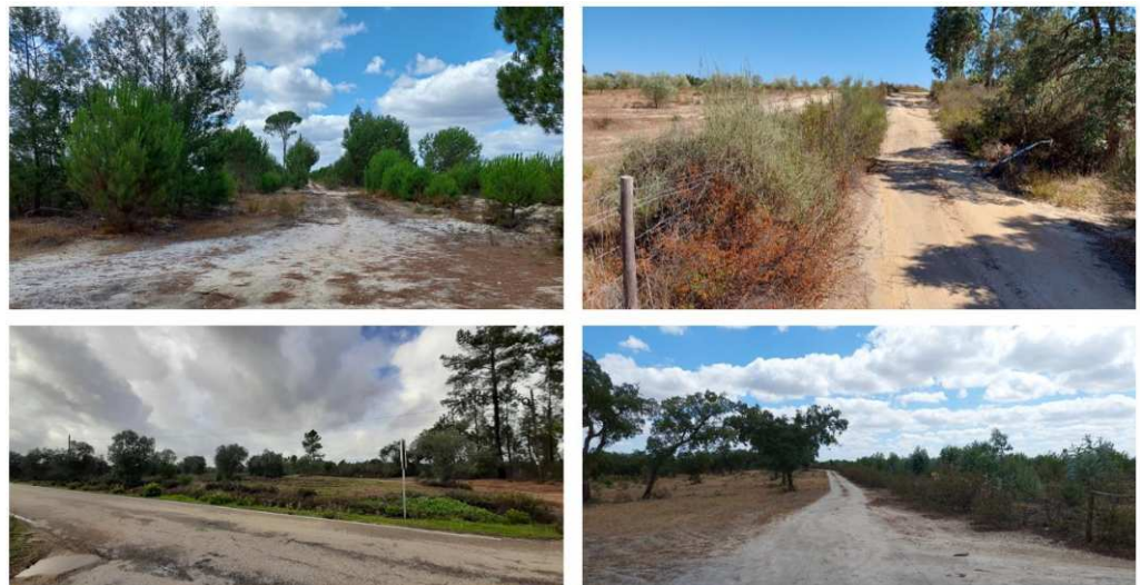
Fotografia 5.1 - Exemplos de acessos existentes no interior da Central Fotovoltaica de Atalaia (CFA)
