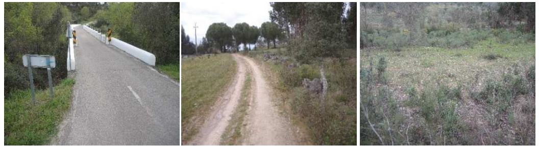
Fotografia 7.41 - Estrada Municipal 531, acesso existente e que será usado; caminho em terra batida a beneficiar; troço do acesso a construir
