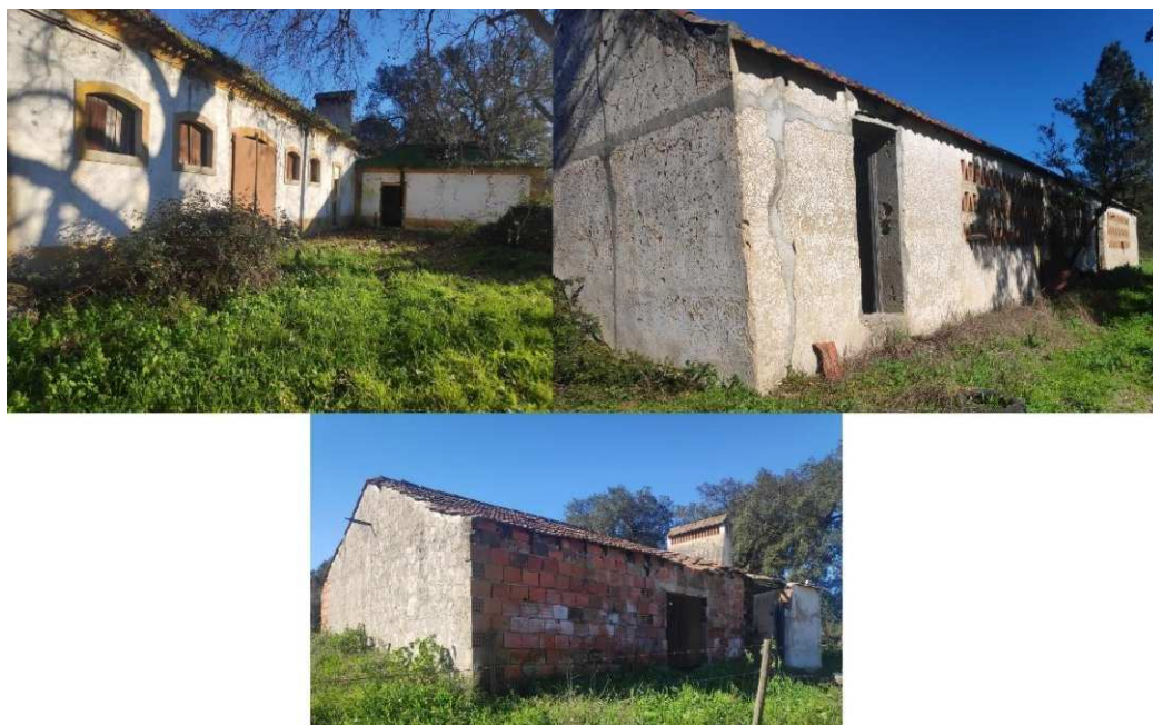
Figura 7.35– Identificação dos locais onde foi observada presença de guano de morcegos na envolvente à área dos trechos da LE Comenda-Cruzeiro
