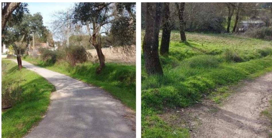
Fotografia 5.3 – Situação do acesso externo a utilizar até à subestação de Comenda
