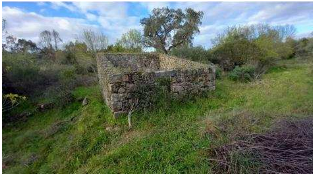
Fotografia 7.49 - CC1 “Vale do Homem”, aqueduto e pequeno edifício de apoio agrícola “Vale do Homem 1”, localizado junto da Rib. a de Sor
