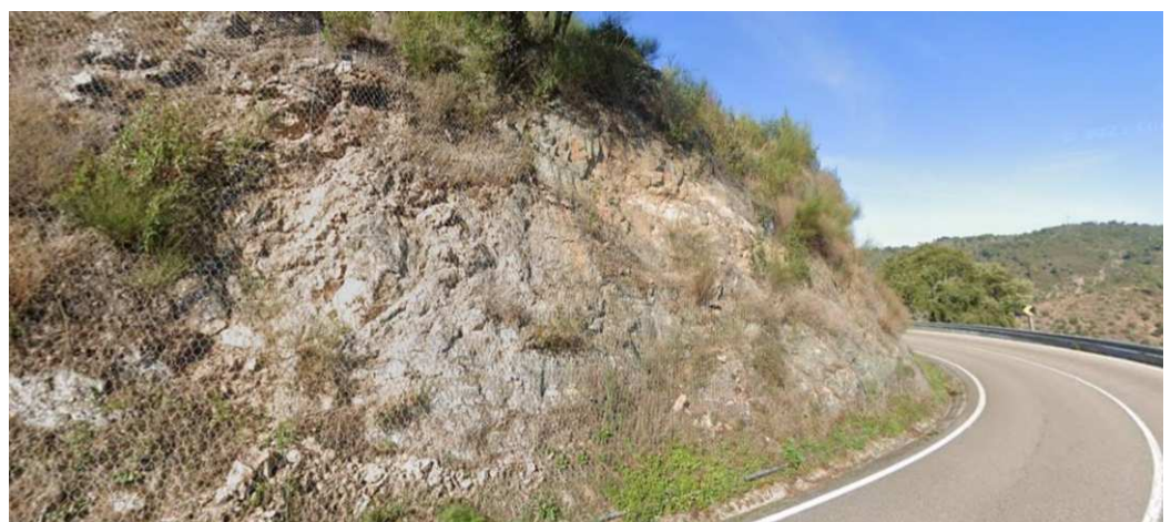
Fotografia 7.5 – Formação granítica na N244 a norte do Gavião, idêntica à que aflora no apoio 7 da linha elétrica de Comenda - Cruzeiro
