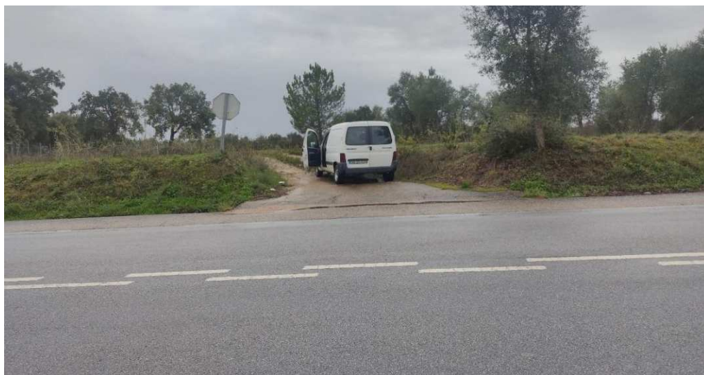
Fotografia 7.13 – EN 118 que atravessa o Norte da AE-CFA
