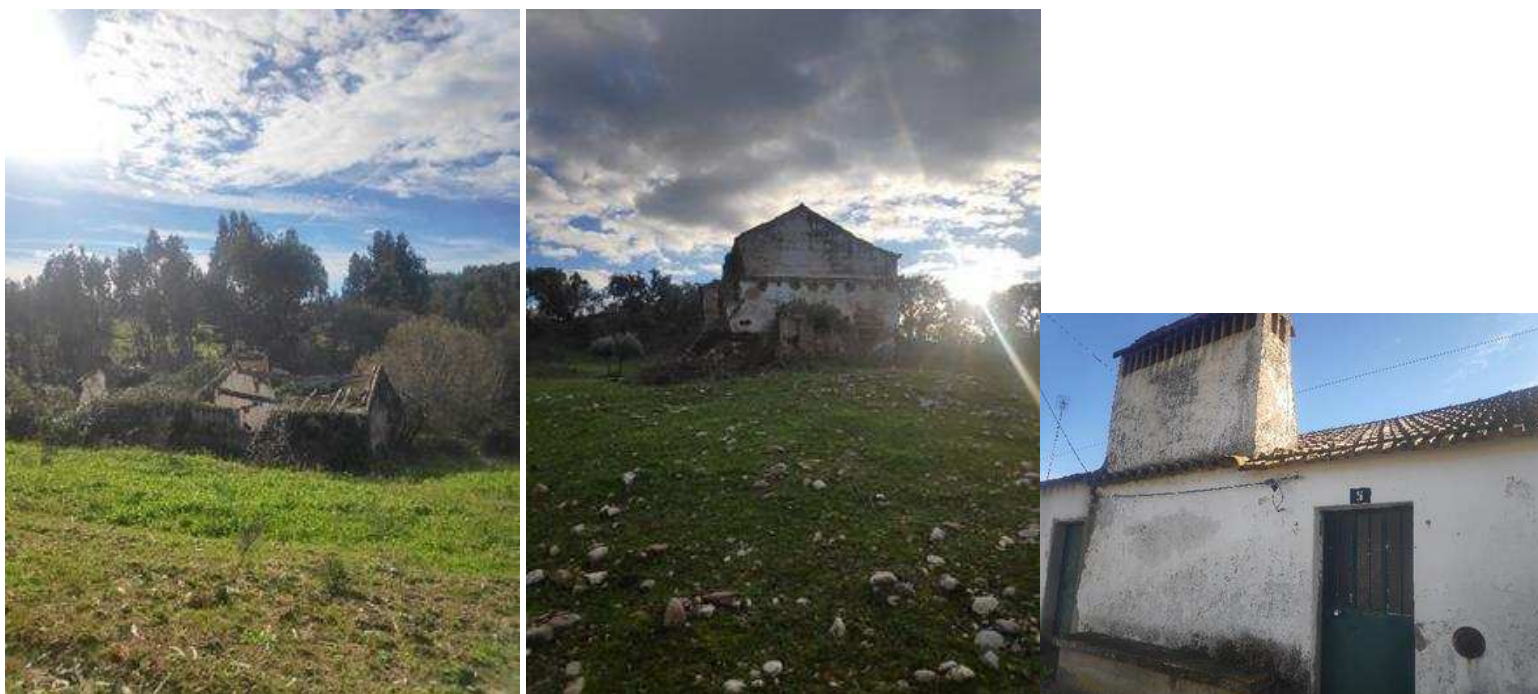
Figura 7.41 – Identificação dos locais onde foi observada presença de guano de morcegos na envolvente da área de estudo da Central Fotovoltaica de Concavada
