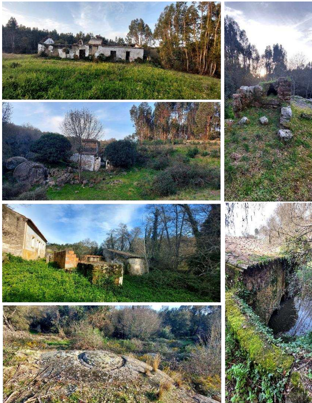
Fotografia 7.48 - Várias estruturas que constituem o “Monte da Azinheira” CC7: Conjunto de várias habitações; Edifício que devia corresponder à casa do moleiro; ruínas de um forno; CC17 “Rib.º da Margem 1” e 18 “Rib.º da Margem 2”, edifício de habitação e outras estruturas e pequena azenha; Bloco com negativo para extração de mó
