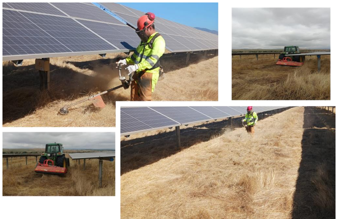
Figura 13 – Exemplo real de controlo de vegetação manual e mecânica pela ENDESA – Medida de Controlo de Vegetação.
