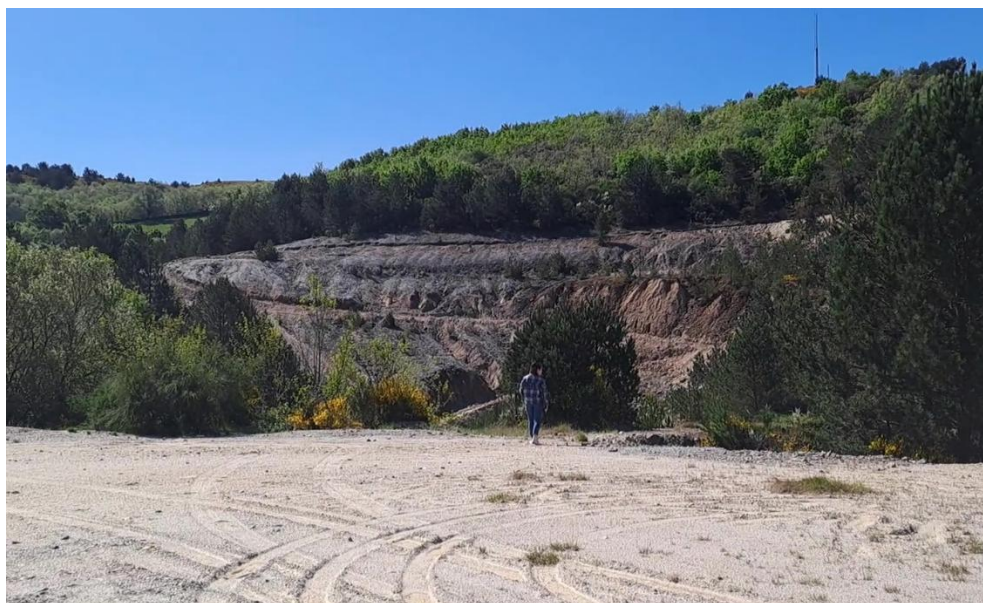
Fotografia 3-2 – Aspeto geral das escombreiras. Declives > 25%, problemas de riscos de erosão
