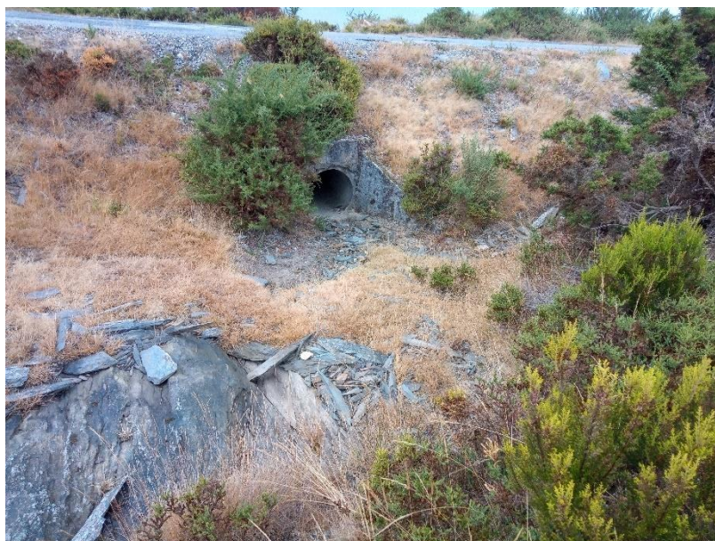
Foto 8 – Linha de água interceptada cerca do km 1+200 do acesso principal. Ribeiro do Porto Velho (zona de atravessamento)
