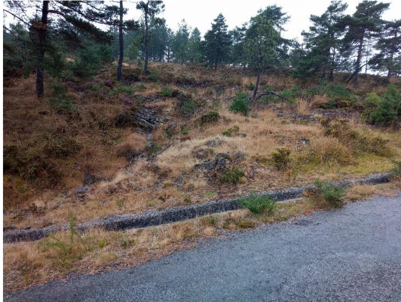
Foto 4 – Linha de água intercetada cerca do km 0+600 do acesso principal (vista para montante)
