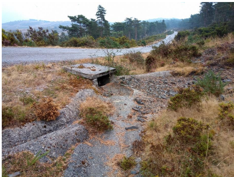
Foto 5 – Linha de água intercetada cerca do km 0+600 do acesso principal (ponto de atravessamento)
