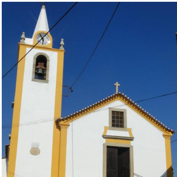
Figura 16. Igreja Matriz de Monte da Pedra
