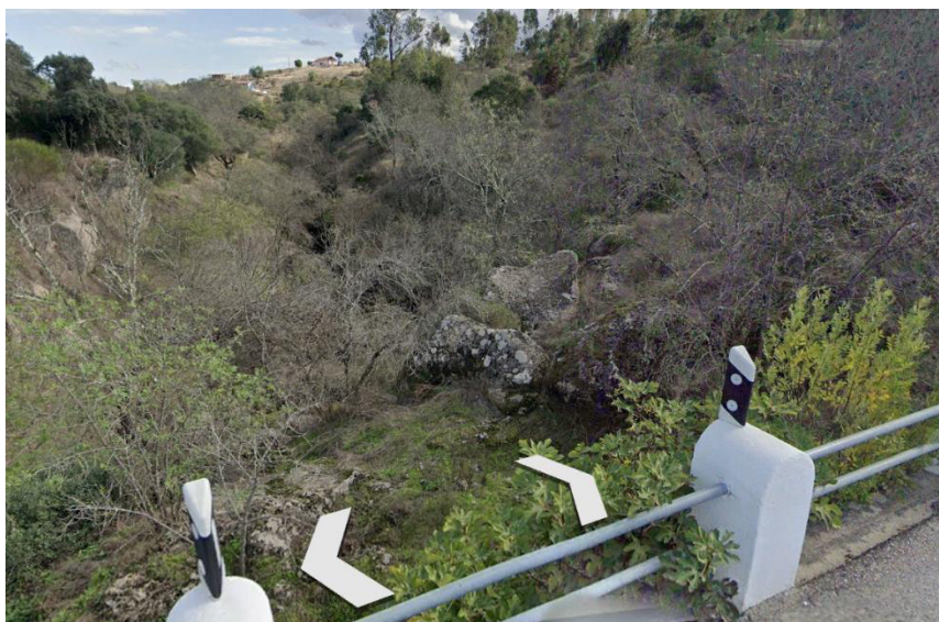
Figura 10. Rio Sor – Lugar do Sume – Ponte – vista de afloramentos rochosos a montante da ponte do Sume
