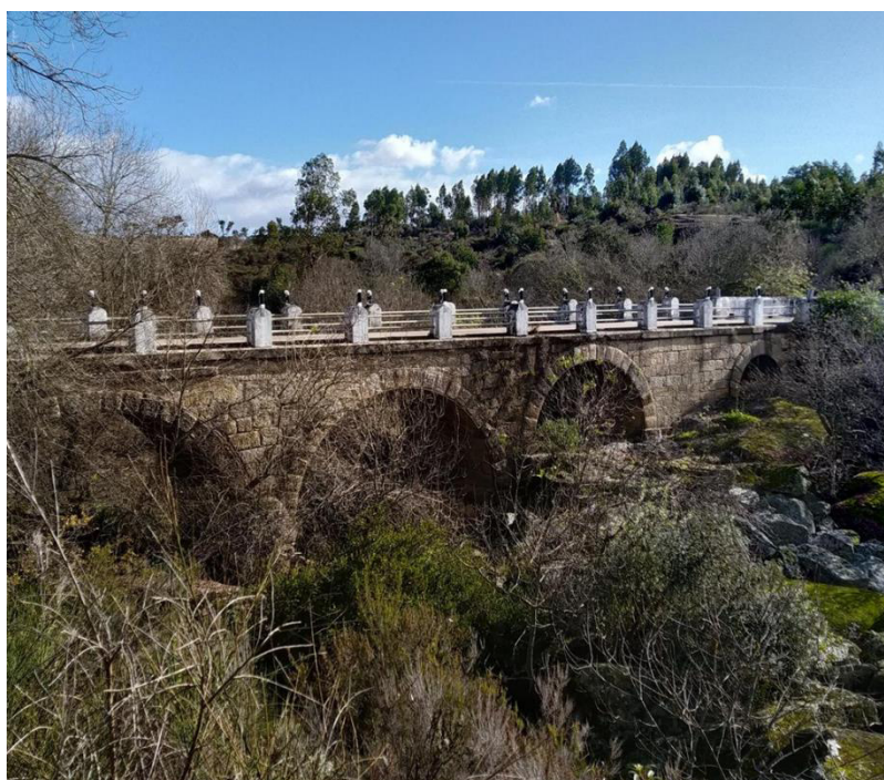
Figura 11. Vista da Ponte do Sume sobre o Rio Sor
