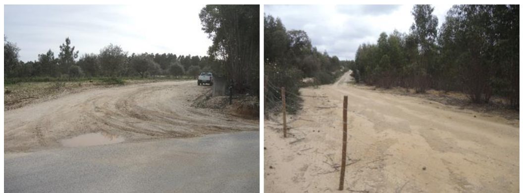
Fotografia 7.40 - Início do acesso externo, com ligação à estrada alcatroada e outra vista do mesmo acesso, junto das parcelas do parque
