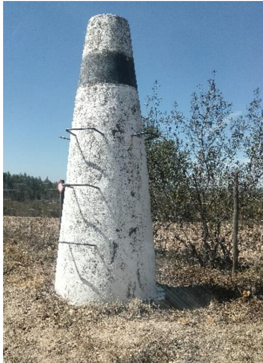
Fotografia 5.3 – Vértice geodésico no interior dos corredores da LE-CFH.SCM
