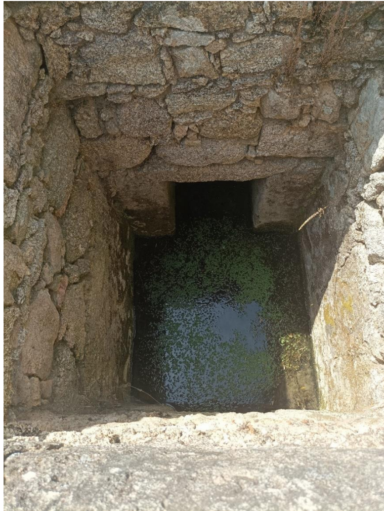
Fotografia 7.12 – Poço identificado no núcleo da subestação da Central Fotovoltaica de Heliade
