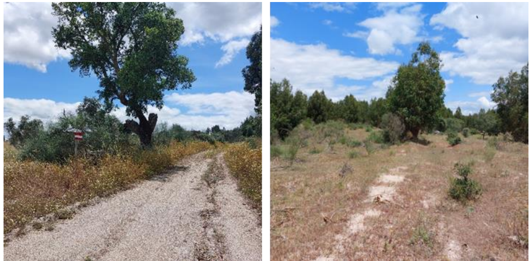
Fotografia 7.30 - Vista geral de um acesso existente, a beneficiar e local onde será construído um acesso interno
