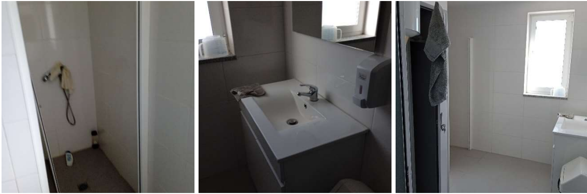
Foto 1: Instalações sanitárias do pavilhão 1 (existente)
