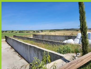
Foto 3 – Silos de betão
