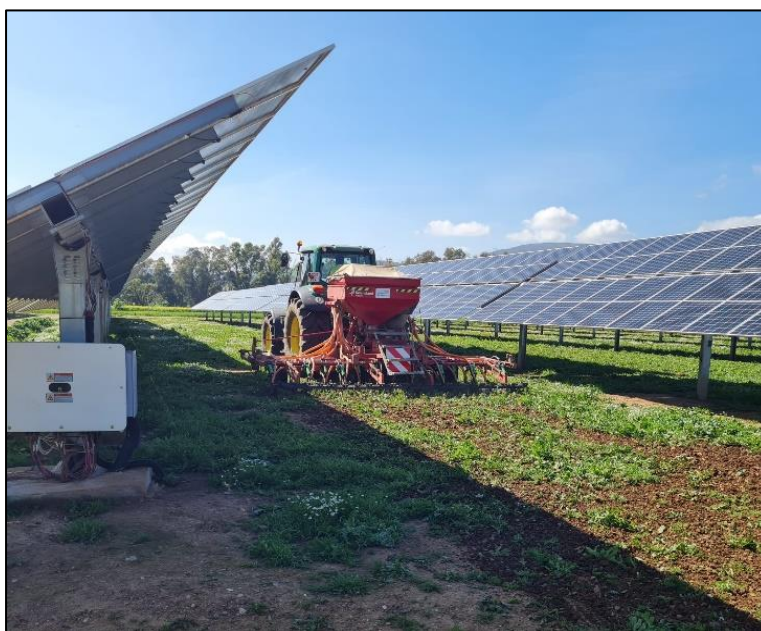
Ilustração 62. Arados em instalações fotovoltaicas.
