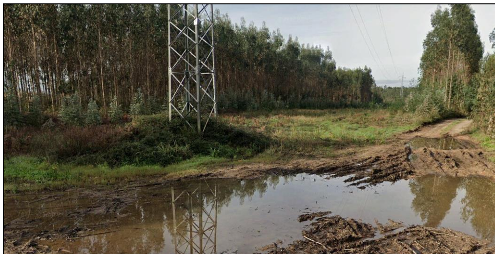
Ilustração 5. Fotografia 3. Corta-fogo para a linha eléctrica.
