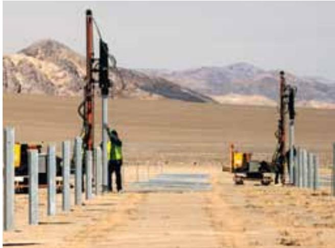
Figura 3.16 – Simplicidade de Instalação dos Parafusos de Fixação
