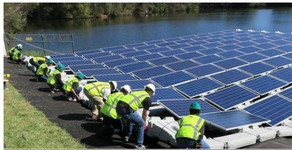
Figura 2: Exemplo do lançamento das unidades flutuantes até à superfície da água (Fonte: D3 Energy).
