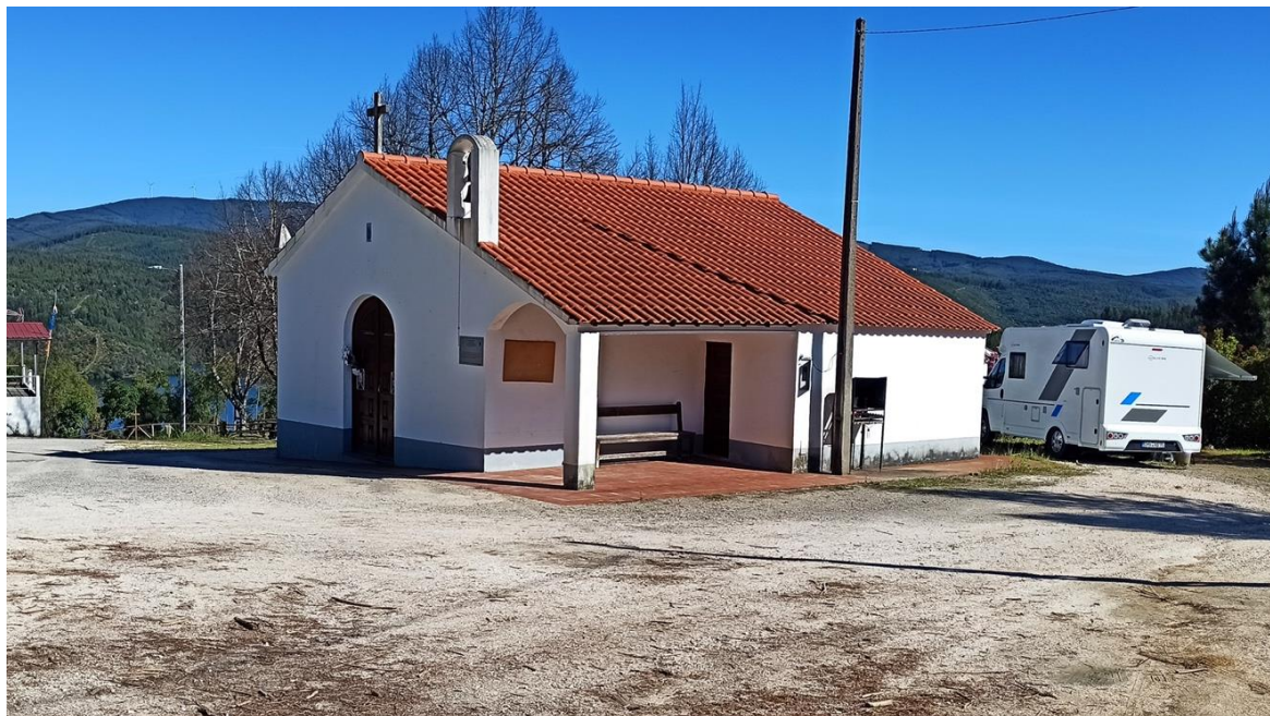
Figura 55: Vista de noroeste da Ocorrência B.
