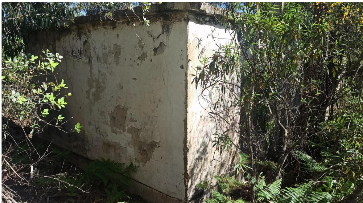
Figura 63: Vista da esquina noroeste da Ocorrência C.
