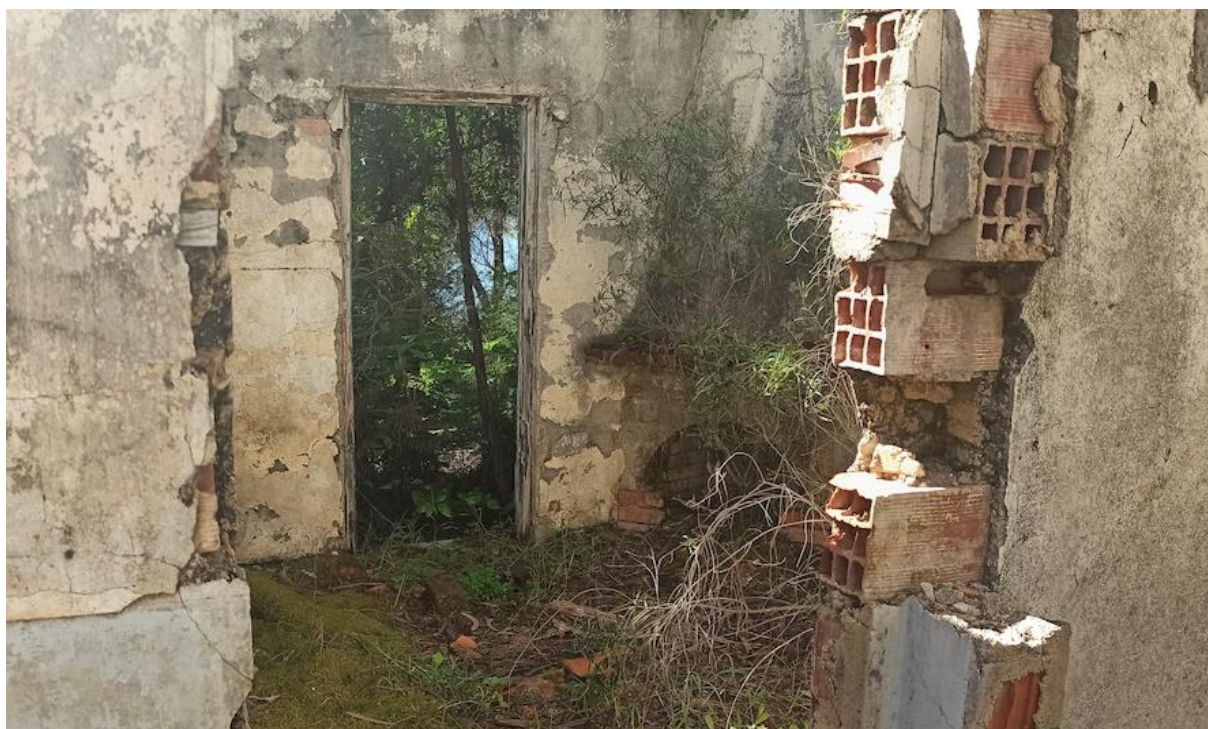
Figura 64: Vista do interior da Ocorrência C (no sentido da entrada, situada na fachada oeste).
