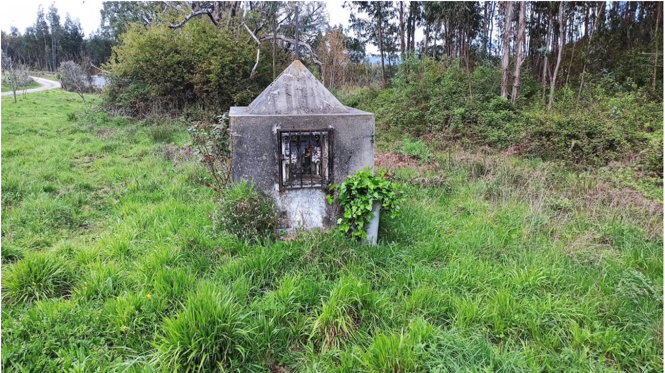
Figura 49: Vista frontal geral da Ocorrência A.
