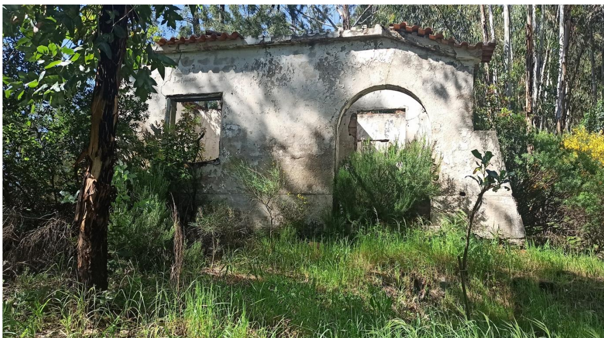
Figura 66: Vista da fachada sul da Ocorrência C.
