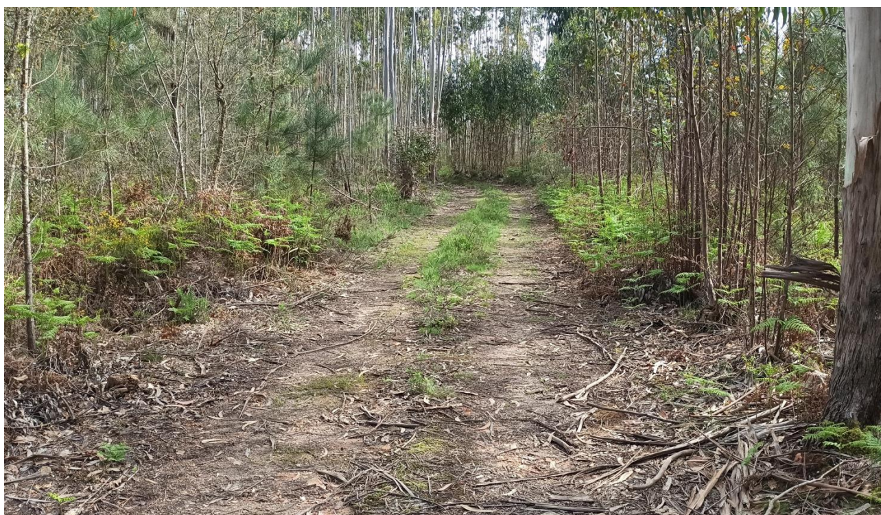
Figura 84: Vista de acesso a beneficiar em direção ao apoio 79 da Linha Elétrica aérea a 60 kV (ponto 14).
