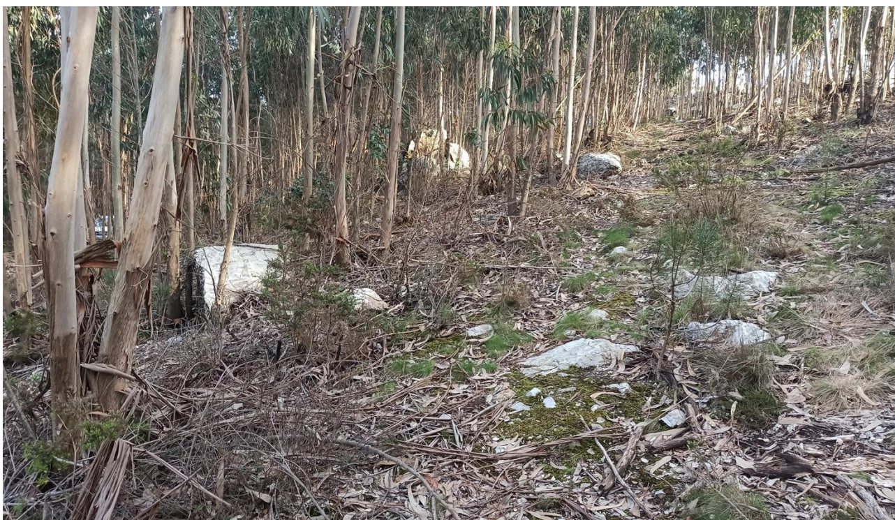
Figura 97: Vista da área de localização do apoio 65 da Linha Elétrica aérea a 60 kV (ponto 27).
