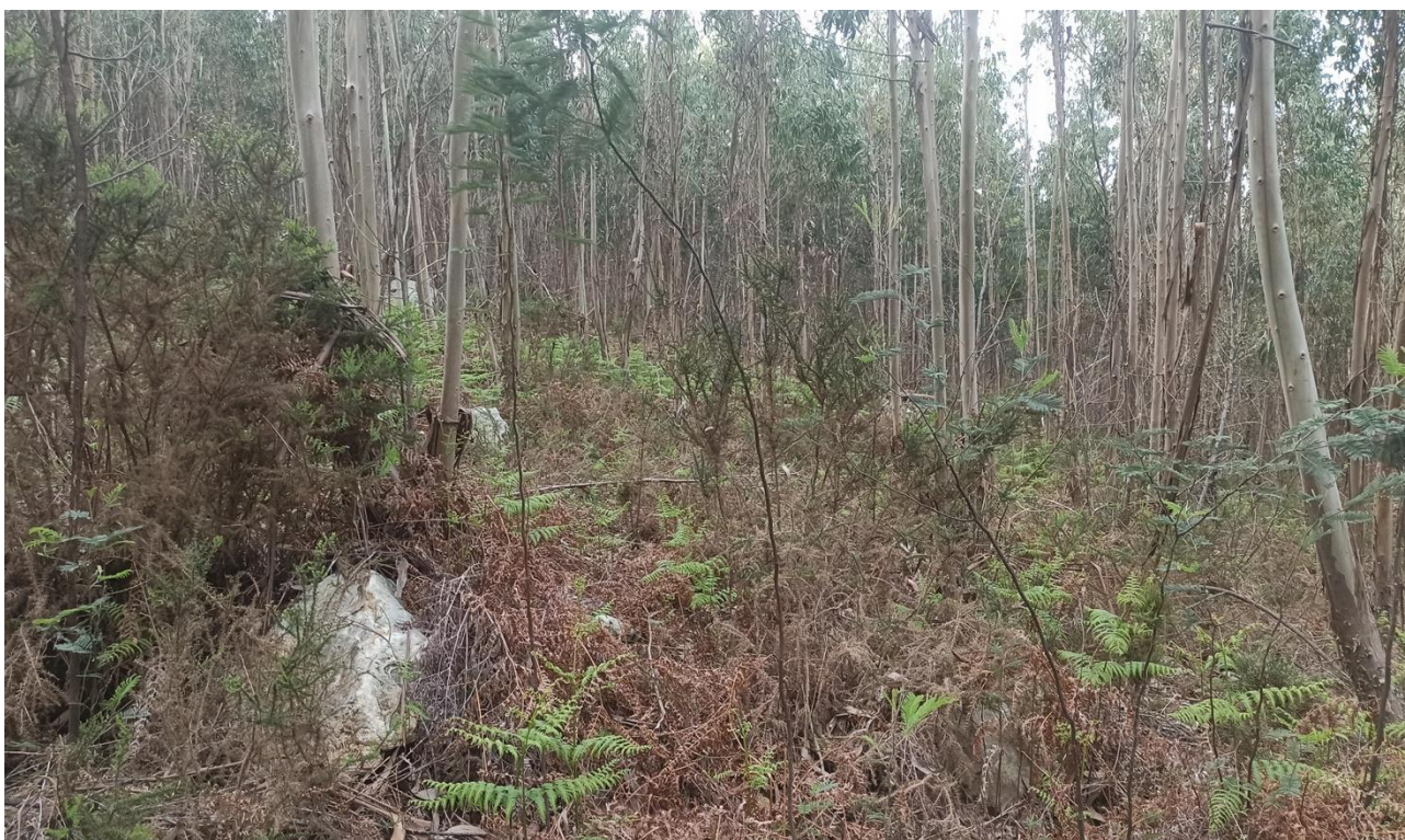
Figura 100: Vista do traçado da Linha Elétrica aérea a 60 kV entre os apoios 63 e 64 (ponto 30).
