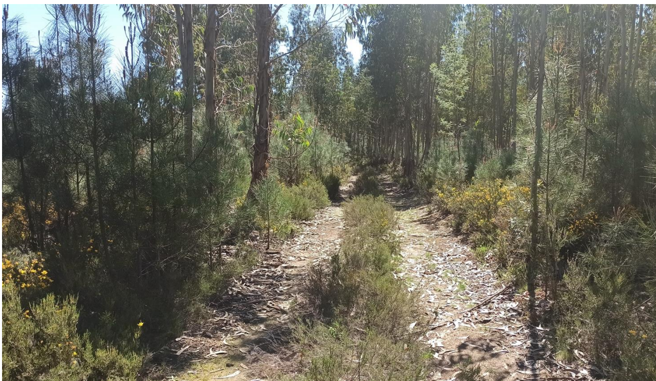
Figura 146: Vista de acesso a reabilitar em direção ao apoio 3 da Linha Elétrica aérea a 60 kV (ponto 76).
