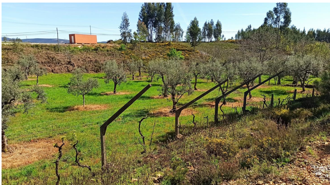
Figura 156: Vista da área de localização do apoio 10 da Linha Elétrica aérea a 30 kV (ponto 86).
