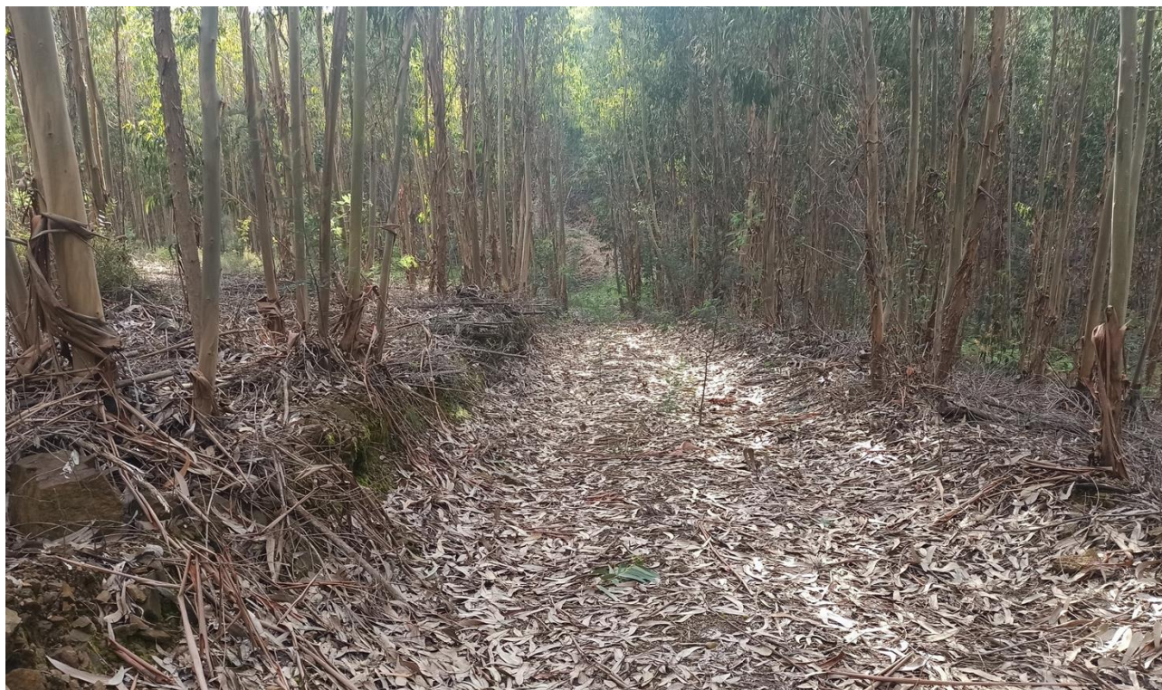
Figura 139: Vista de acesso a reabilitar entre os apoios 9 e 10 da Linha Elétrica aérea a 60 kV (ponto 69).
