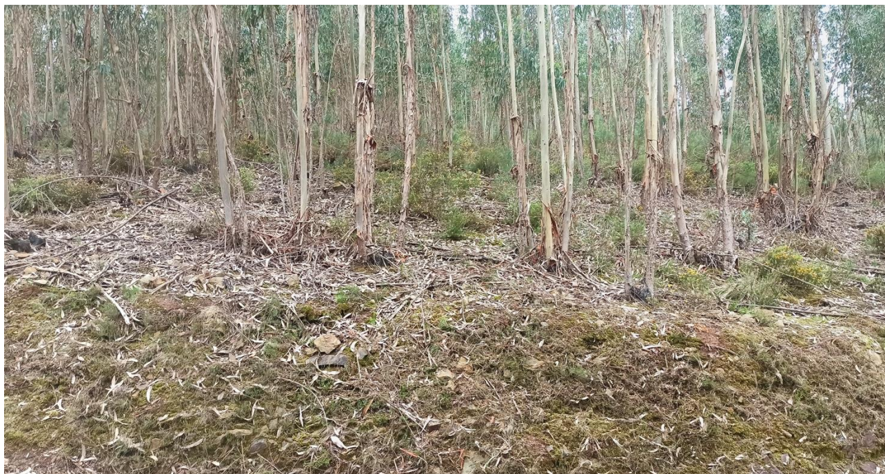
Figura 111: Vista do traçado da Linha Elétrica aérea a 60 kV junto ao apoio 50 (ponto 41).
