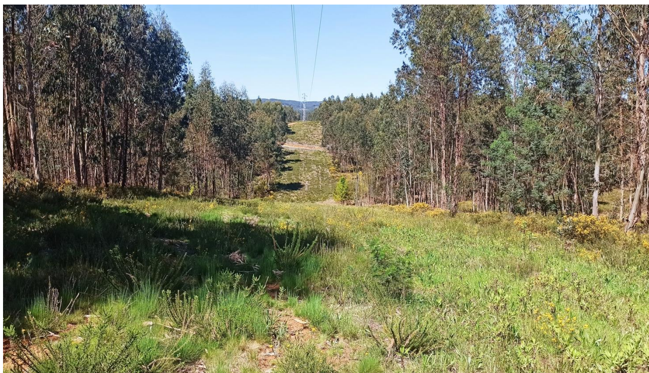
Figura 153: Vista de acesso a construir em direção ao apoio 13 da Linha Elétrica aérea a 30 kV (ponto 83).
