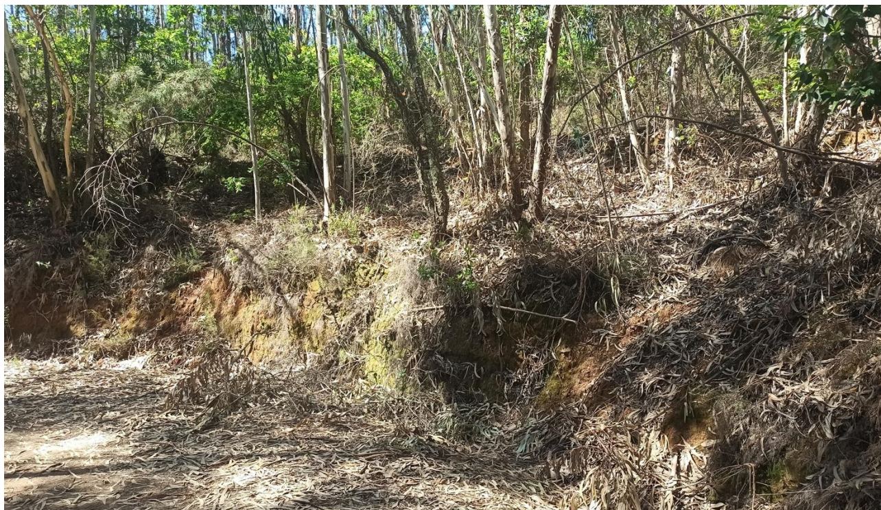
Figura 167: Vista de acesso a construir em direção ao apoio 1 da Linha Elétrica aérea a 30 kV (ponto 97).
