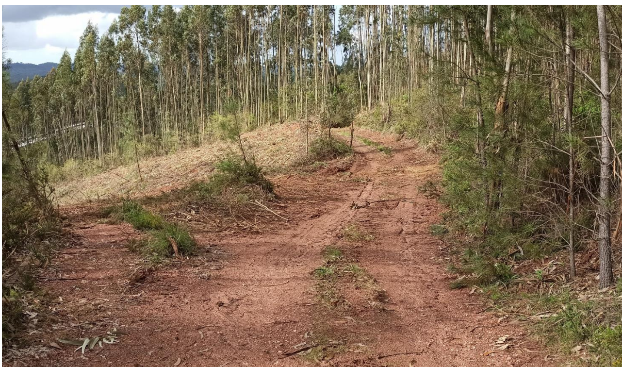
Figura 88: Vista de acesso a beneficiar em direção ao apoio 77 da Linha Elétrica aérea a 60 kV (ponto 18).
