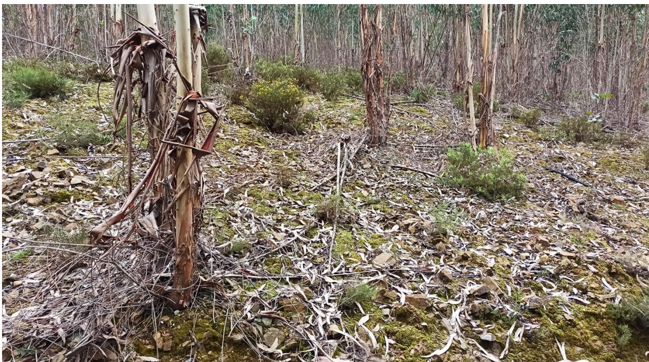
Figura 106: Vista do traçado da Linha Elétrica aérea a 60 kV entre os apoios 52 e 53 (ponto 36).
