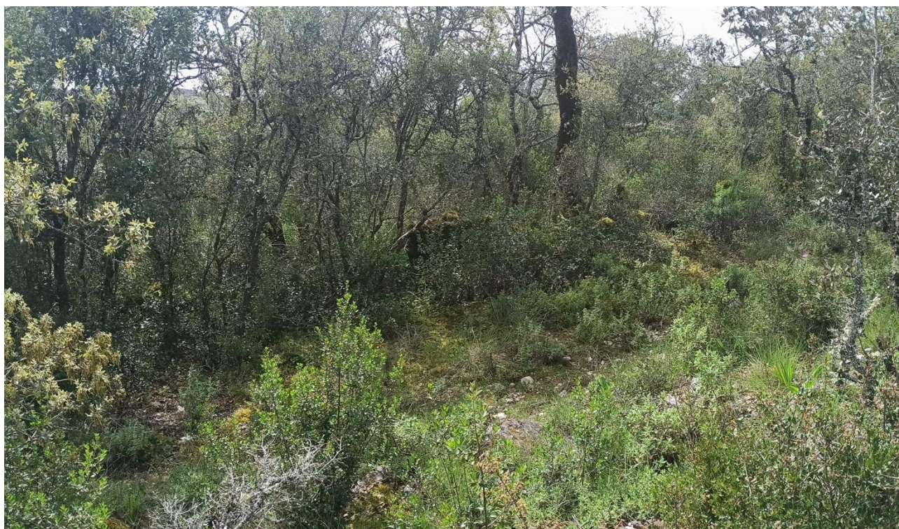
Figura 77: Vista do traçado da Linha Elétrica aérea a 60 kV junto ao apoio 86 (ponto 7).
