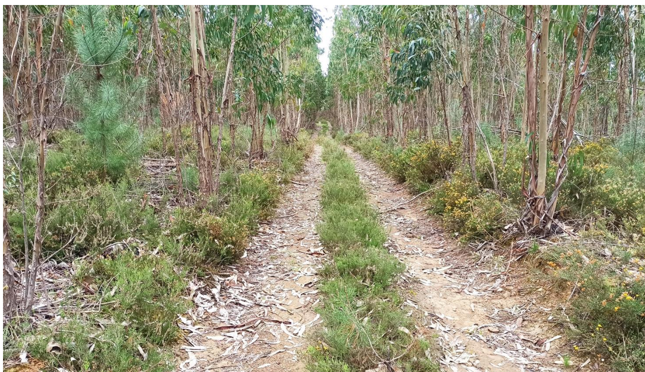
Figura 108: Vista da área de localização do apoio 52 da Linha Elétrica aérea a 60 kV (ponto 38).
