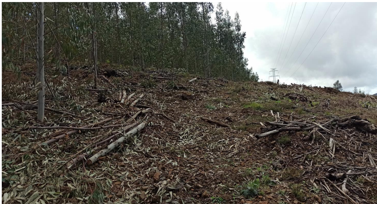
Figura 123: Vista de acesso a construir em direção ao apoio 38 da Linha Elétrica aérea a 60 kV (ponto 53).
