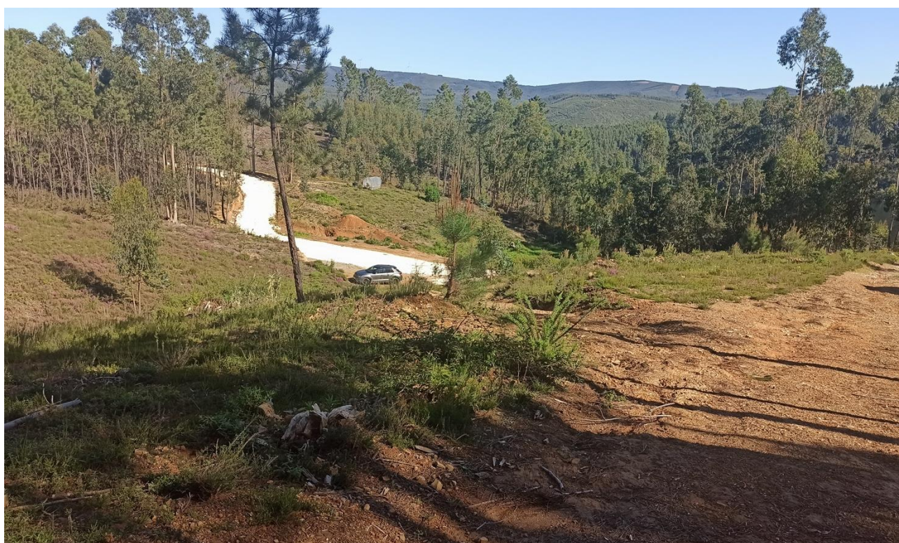
Figura 160: Vista da área de localização do apoio 4 da Linha Elétrica aérea a 30 kV (ponto 90).
