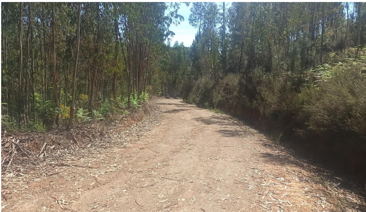
Figura 171: Vista de acesso a beneficiar (ponto 101).
