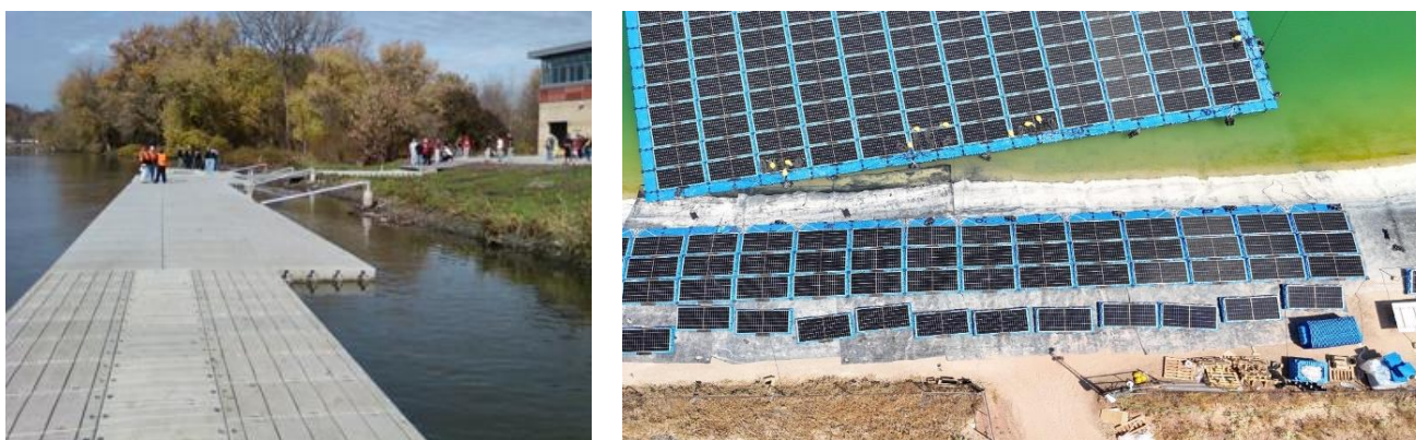
Figura 5: Exemplo de uma área de circulação flutuante (Esquerda. Fonte: ISIGENERE); Exemplo de uma zona de montagem e lançamento de estruturas flutuantes (Direita. Fonte ISIGENERE).
