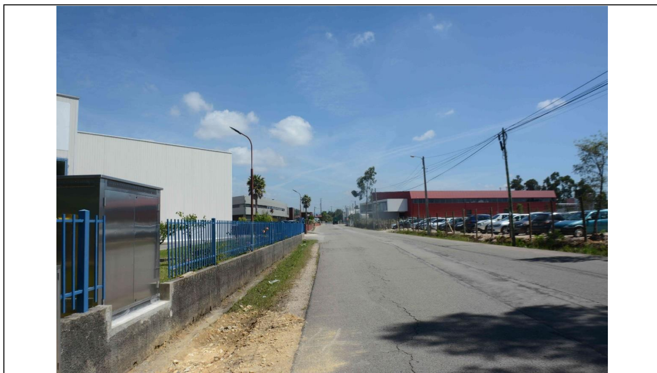
Figura 5.100: Estrada da Zona Industrial (o Projeto encontra-se à esquerda) com vista na direção NNE
