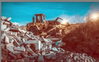
Resíduos de obras
