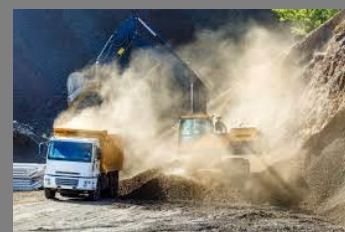
Pó gerado pelas atividades de construção
