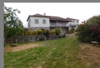
Casa da Timpeira, património mais próxima da área de intervenção
