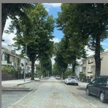
Arborização dos arruamentos
