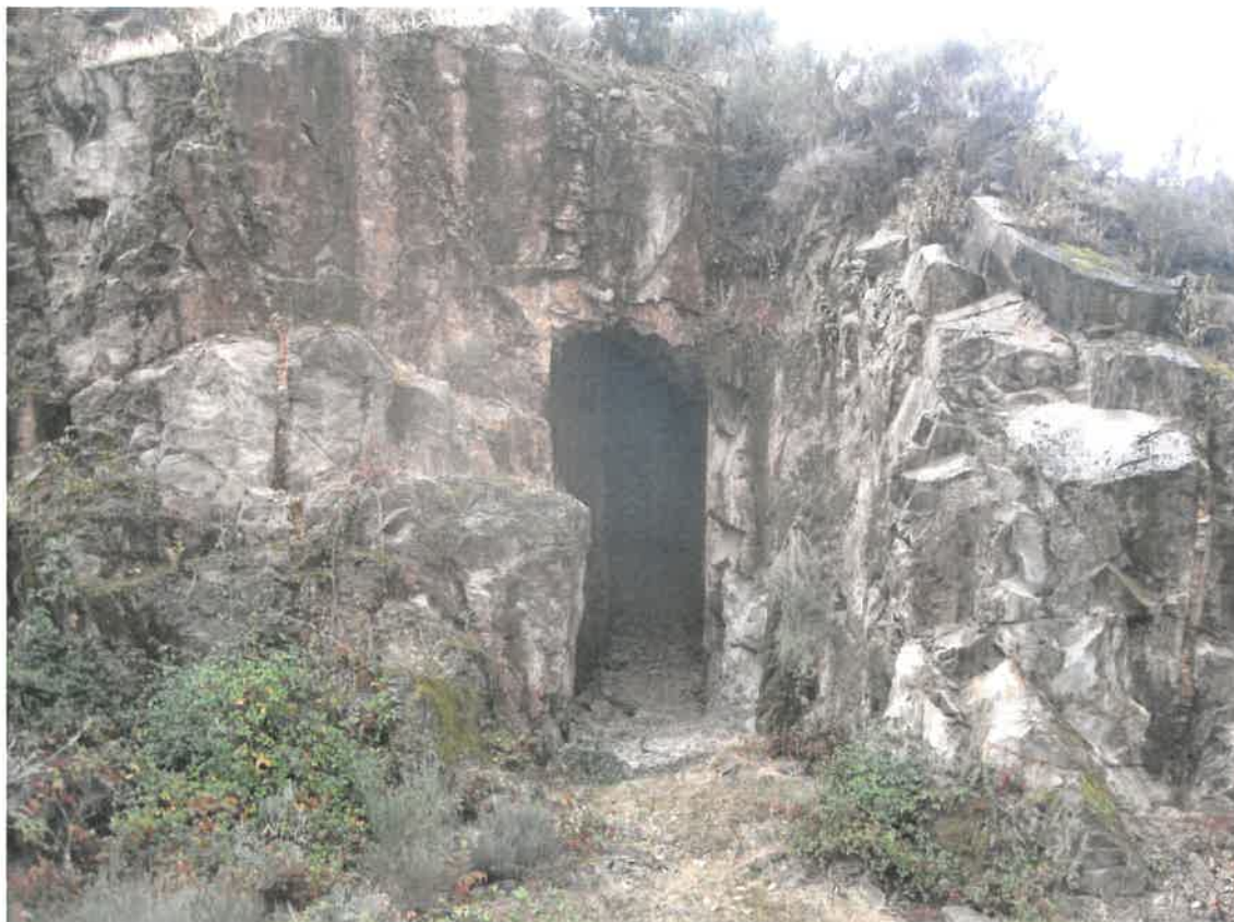
Figura 38 - Aspeto da antiga Mina da Argemela - emboquilhamento de uma das galerias.
