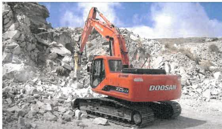
Figura 17 – Escavadora giratória equipada com martelo hidráulico.
