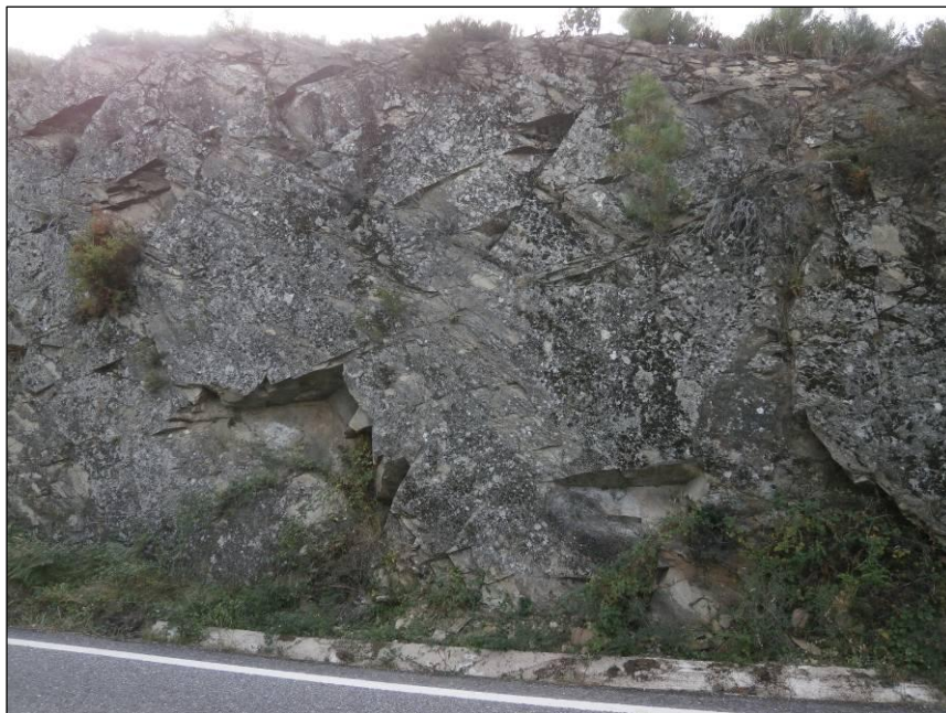
Figura 36 – Observação das principais famílias de diáclases, presentes no substrato rochoso do talude a nordeste da área em estudo junto à EN343.
