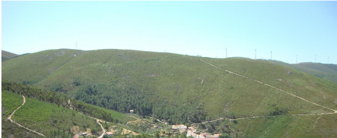
Figura 125 - SUP 2 vista para o Parque Eólico
