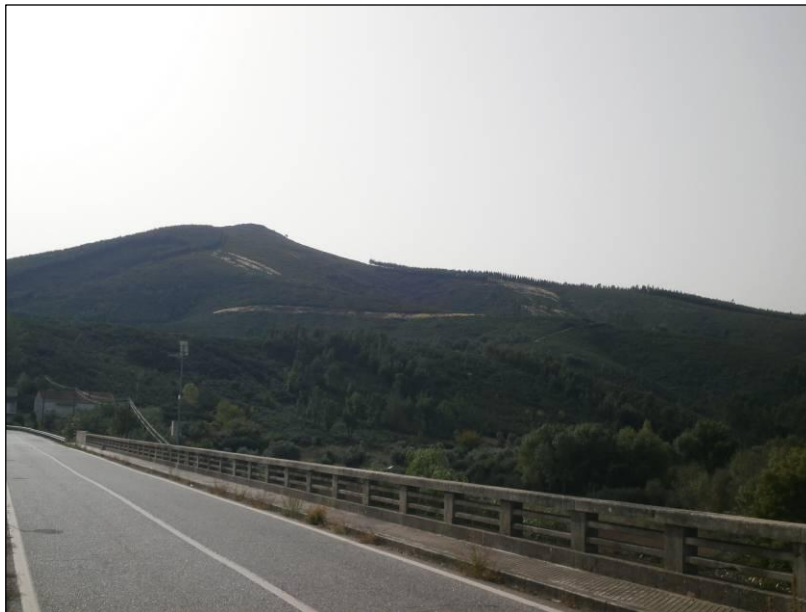
Figura 53 – Vista para sul na Ponte do Rio Zêzere com observação do Cabeço da Argemela ao fundo
