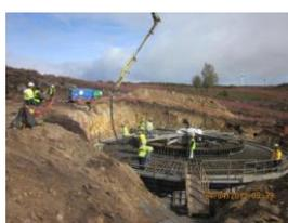
Execução da armadura da fundação do aerogerador
