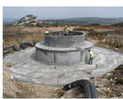
Betonagem da fundação do aerogerador
