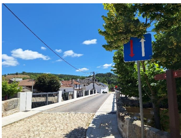
Figura 3 - Ponte existente sobre o Rio Igrejas com passagem alternada
