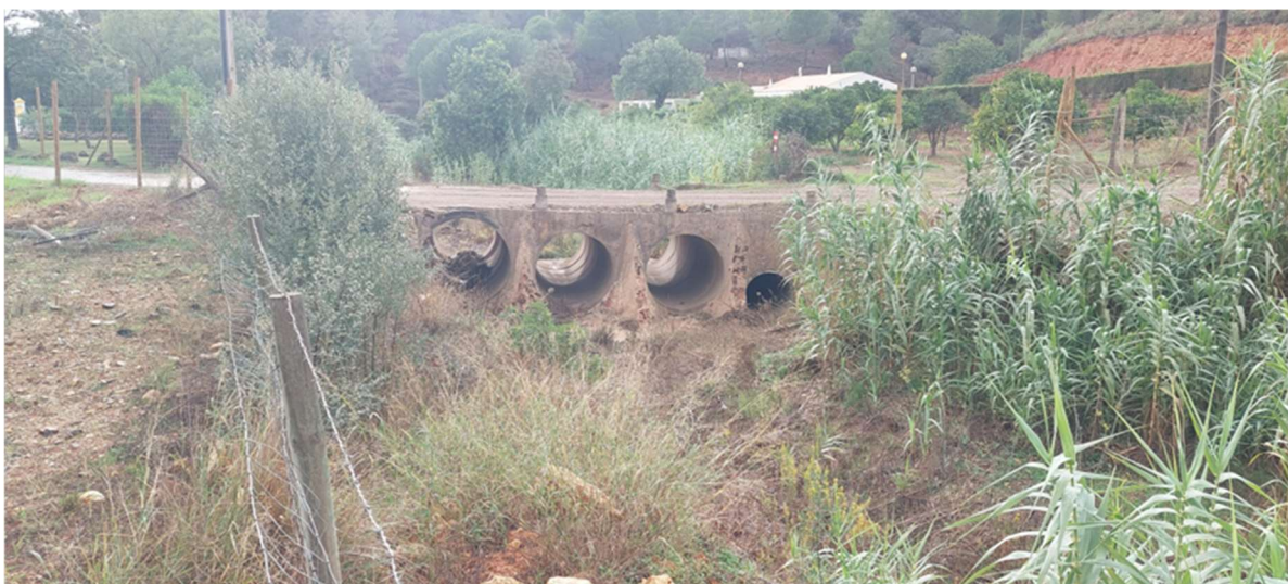
Figura 2.13 | Vista para aquedutos em manilhas no ribeiro da Pontinha
