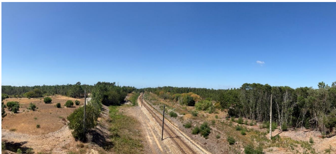
Figura 4.58 – Via ferroviária (Ramal de Sines) presente na área em estudo.
