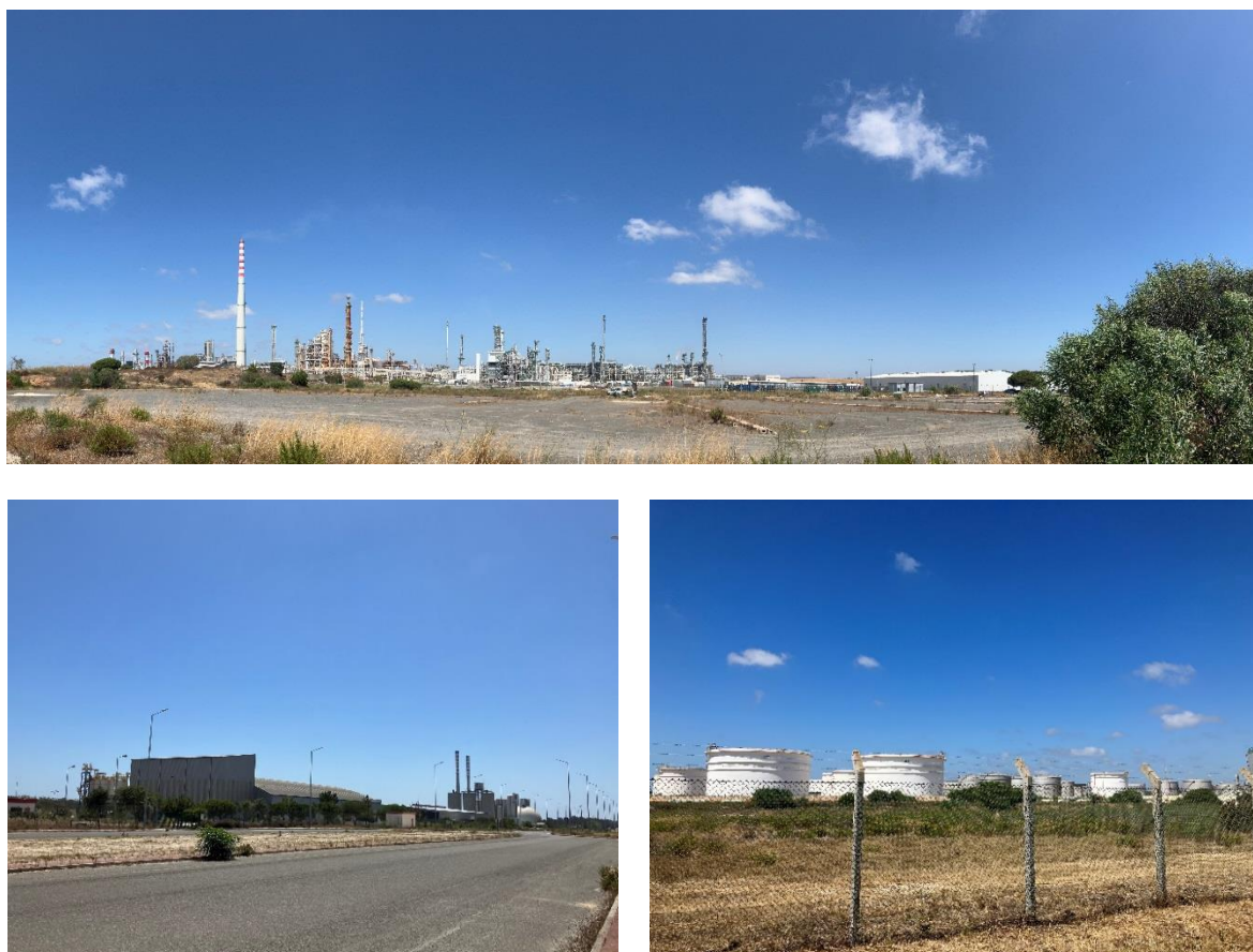
Figura 4.52 – Ocupação industrial na envolvente do traçado das linhas elétricas em estudo, inserida na ZILS
