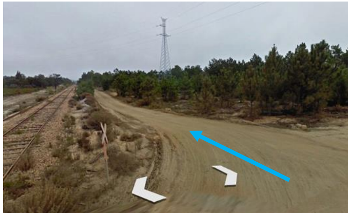
Figura 3.19 – Acesso aos apoios 2 a 8(SC2) da estrada local ao caminho existente
