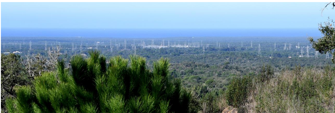
Figura 6.1 – Aspeto da zona envolvente à subestação de Sines a partir da zona sul da serra de Grândola, percebendo-se a elevada densidade de apoios de linha existentes na aproximação à subestação.
